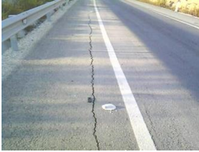
Figura 1.- Grietas constructivas
