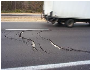
Figura 2.- Grietas parabólicas
