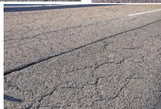
Envejecimiento por vertido de sales y bajas temperaturas.
