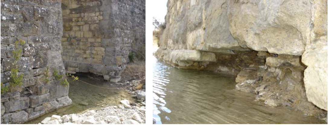
Figura 5.8. Fábrica de un zócalo-zapata de estribo.
