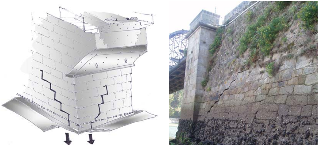
Figura 5.19. Daños en estribos y muros derivados de fallos en la cimentación [1].
