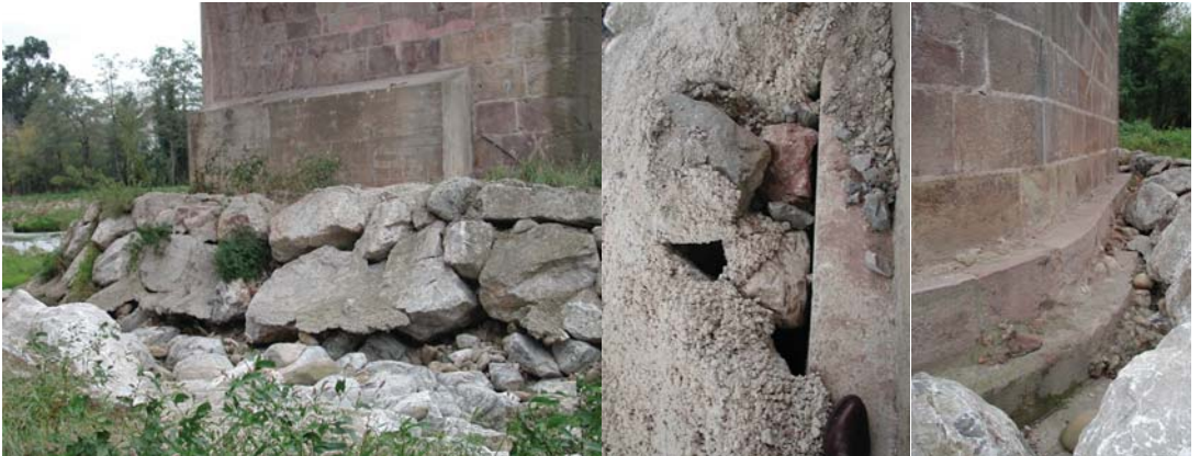
Figura 5.9. Defensas en forma de pedraplén y manto de hormigón.
