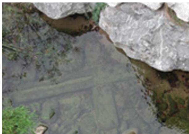
Figura 5.7. Emparrillado de madera en la cara inferior de un encepado.
