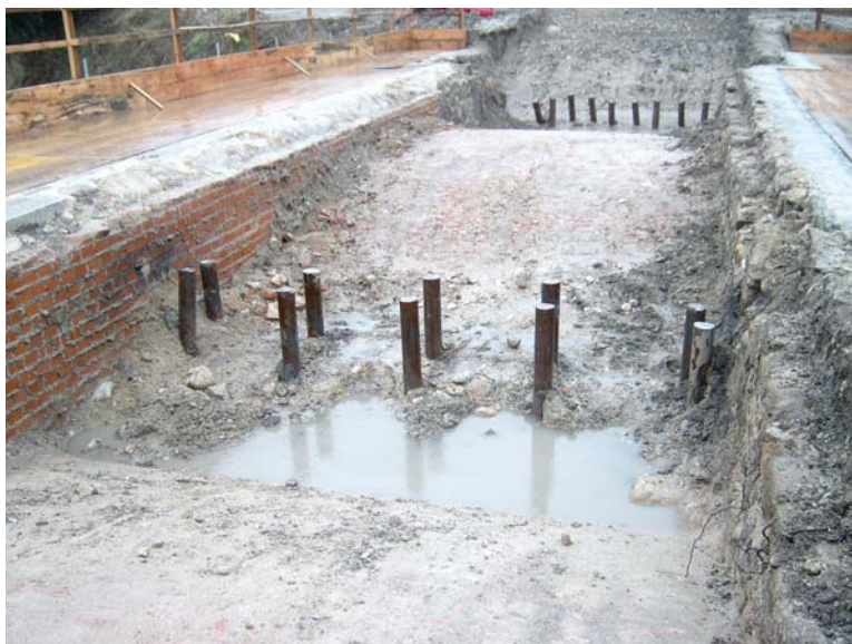
Figura 5.25. Recalce del puente de Villamanta.
