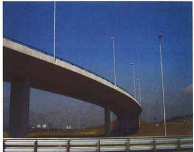
Se han construido dos grandes viaductos: el primero de ellos, de 126 m de longitud total; y, el segundo, de 194 m de longitud. La máxima luz parcial es de 37 m; y las dos estructuras están formadas por tableros continuos realizados por medio de vigas-cajón postesadas, monocelulares y de planta curva.
