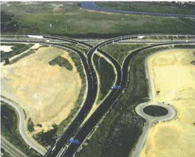
Se han construido dos grandes viaductos: el primero de ellos, de 126 m de longitud total; y, el segundo, de 194 m de longitud. La máxima luz parcial es de 37 m; y las dos estructuras están formadas por tableros continuos realizados por medio de vigas-cajón postesadas, monocelulares y de planta curva.
