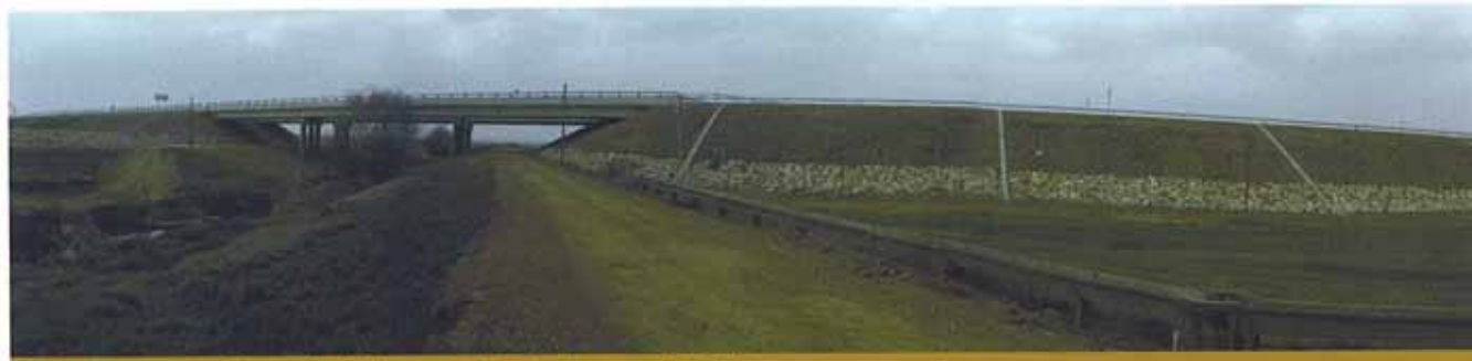
En la imagen, el viaducto de Ucieza en el tramo Amusco-Frómista.
