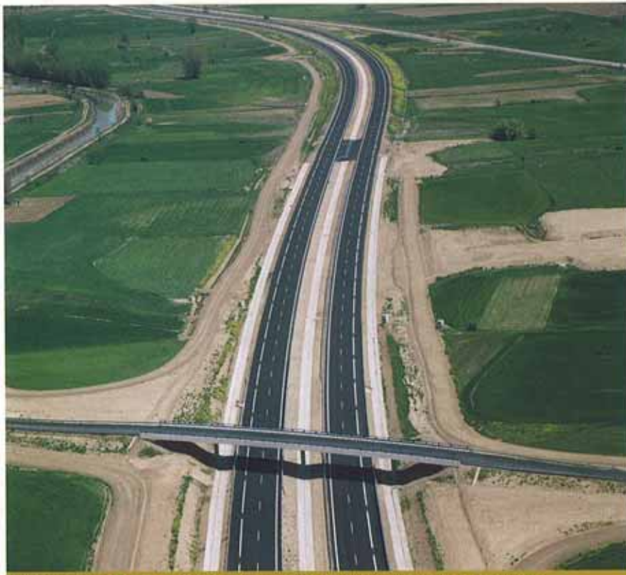
Enlace con la N-611 y el Canal de Castilla en el tramo Amusco-Frómista.
