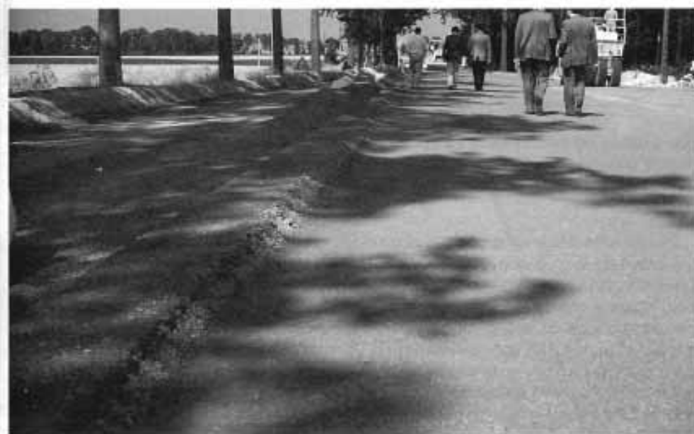
Cordon central de material sin compactar en la union de semibandas de hormigonado.
