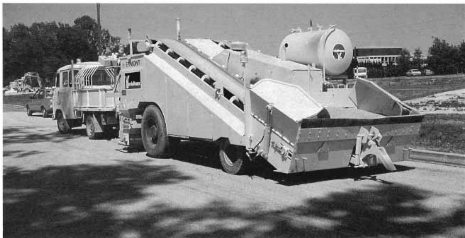
Extensión de arena para protección del riego de curado.
