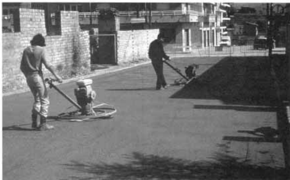
Fratasado mecánico con «helicóptero» para generación de textura superficial
