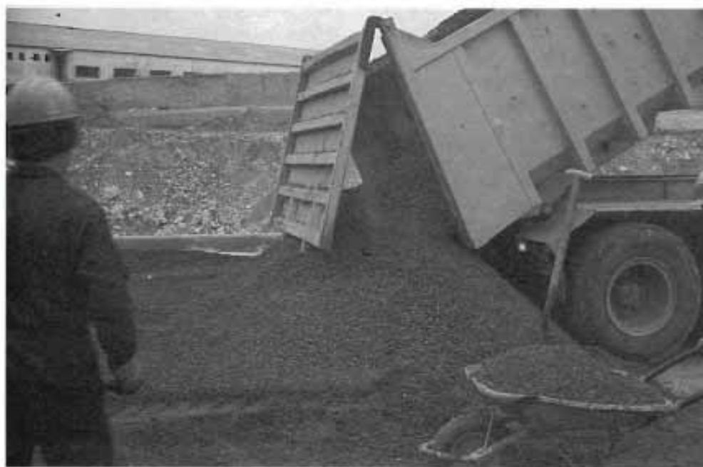
Descarga de hormigón compactado transportado en camión volquete.
