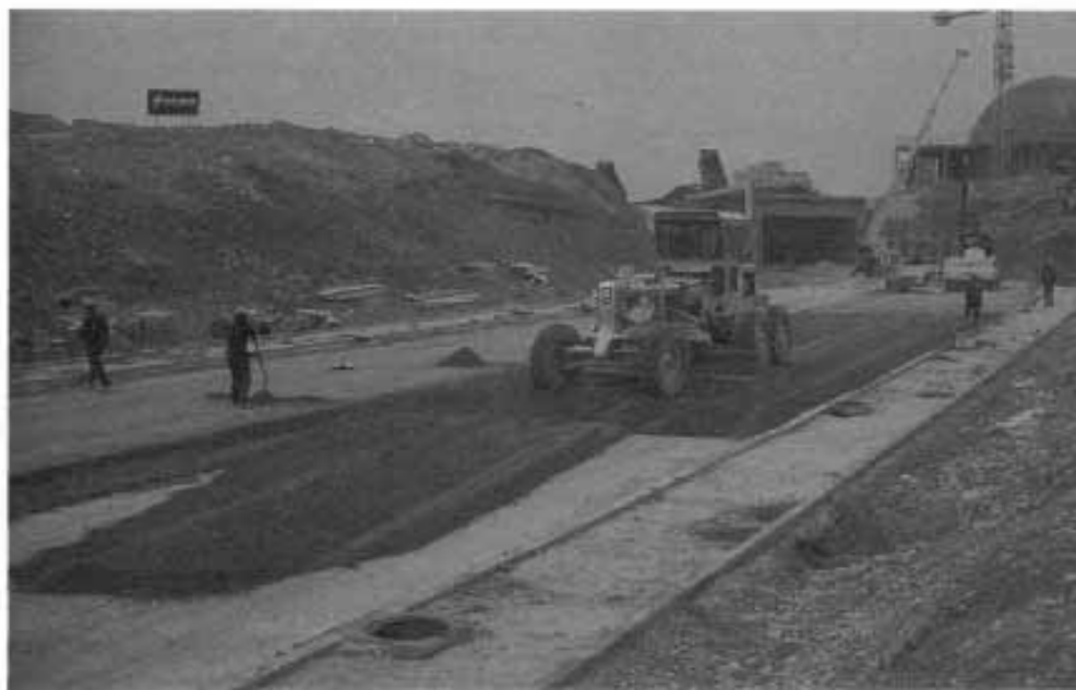
Extendido con motoniveladora.
