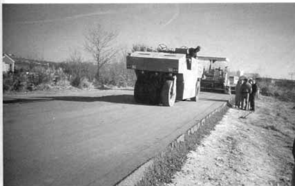
Compactación: compactador de neumáticos.
