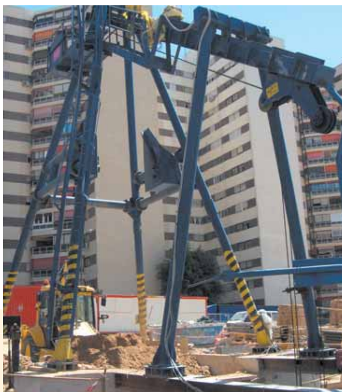
Pozo de acceso para la excavación del túnel que, posteriormente, se ha utilizado como salida de emergencia.
