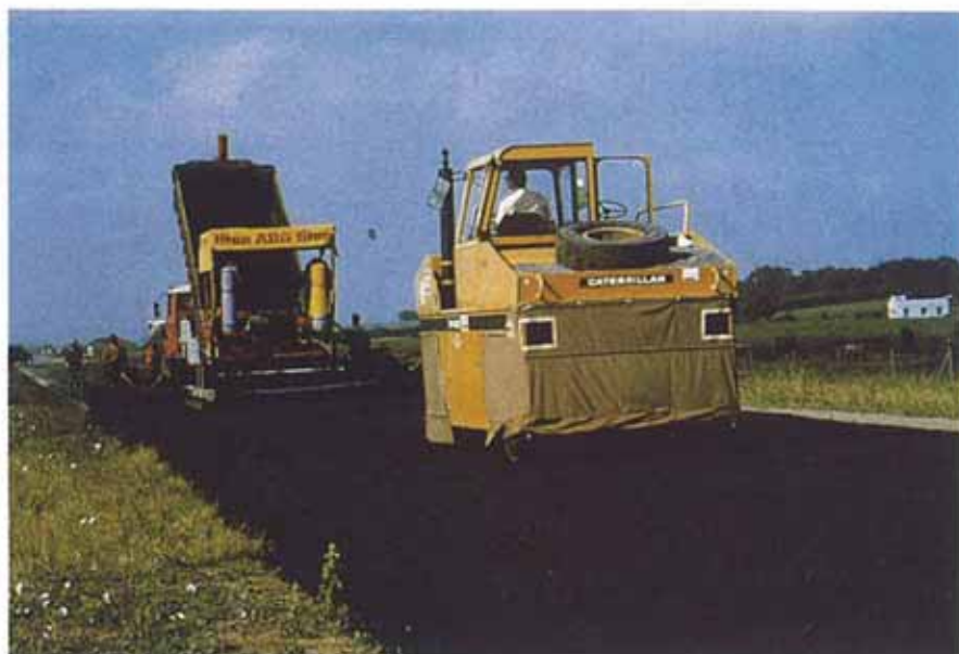
Refuerzo de firme con mezcla bituminosa en caliente.
