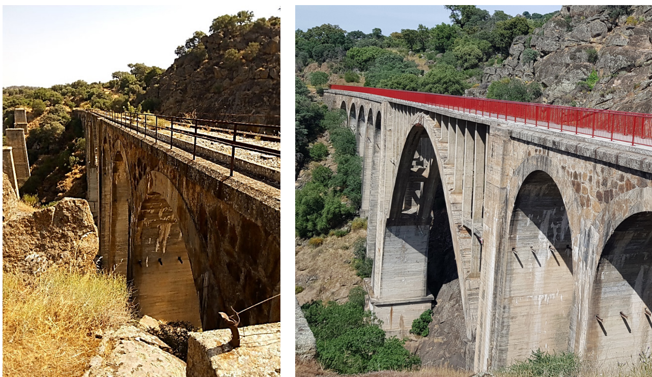
Figura 1. Puente FC Plasencia-Astorga sobre el río Jerte (Plasencia), antes y después de su transformación. A la izquierda se observan las pilas del anterior puente metálico
