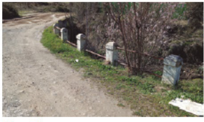
Figura 23 Carretera: N-432 Provincia: Jaén Coordenadas: X: -3.899 Y: 37.433 Tipología: Valla. Postes de hormigón y durmientes metálicos. No tipificada.
