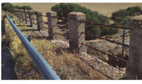
Figura 24 Carretera: Transferida indeterminada (N-IV) Provincia: Ciudad Real Coordenadas: X: -3.501 Y: 38.483 Tipología: Valla. Postes de hormigón y durmientes metálicos. No tipificada.
