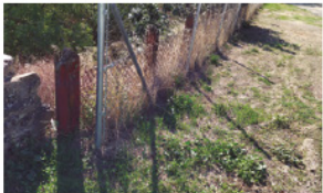
Figura 19 Carretera: Transferida indeterminada (N-IV) Provincia: Ciudad Real Coordenadas: X: -3.497 Y: 38.414 Tipología: Valla metálica. Postes de madera y malla metálica. Circuito Nacional de Firms Especiales (1926/1939).
