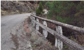
Figura 22 Carretera: A-23 (N-330) Provincia: Huesca Coordenadas: X: -0.378 Y: 42.372 Tipología: Valla de hormigón. Postes curvos y durmientes de hormigón. No tipificada.
