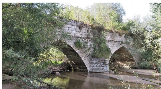
Figura 4. Arrastres de troncos y maleza bajo el arco derecho
