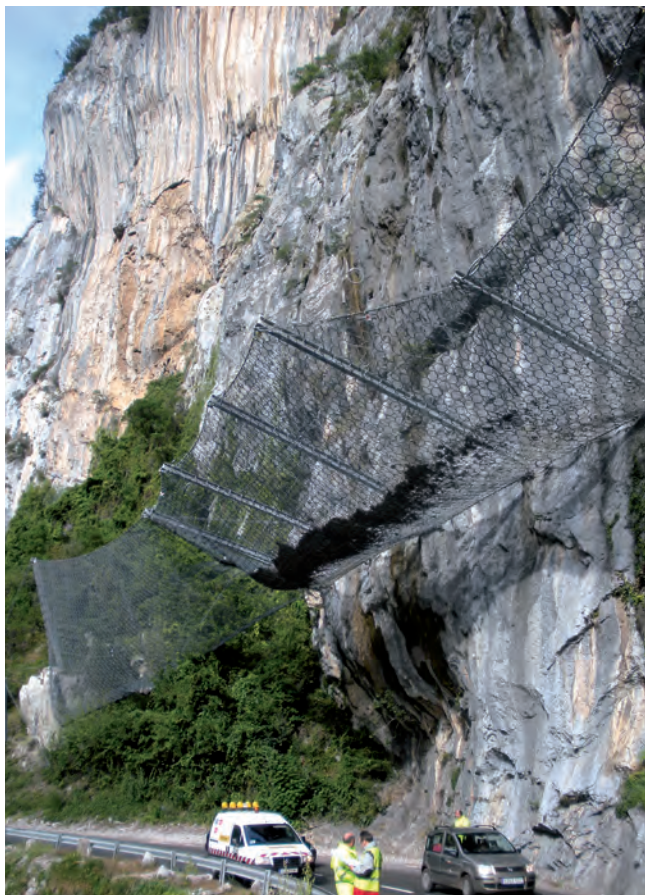
Figura 20. Pantallas dinámicas de tipo galería ancladas a la pared rocosa, a la altura del p.k. 161,2
