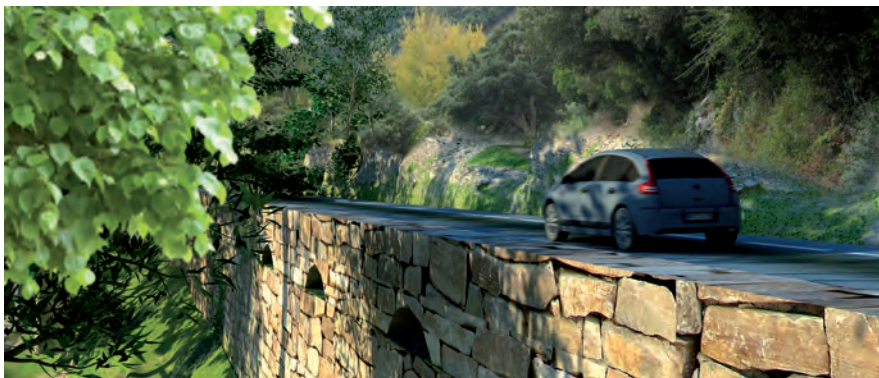
Figura 10. Simulación de las soluciones previstas para muros y pretilos, con pasos para pequeños invertebrados
