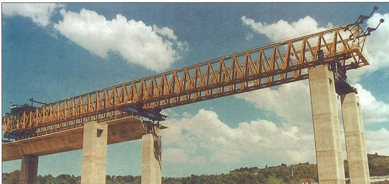
La cimbra se desliza por encima del tablero con un carro elefante auxiliar que descarga y lleva la dovela hasta donde la toma el cabrestante, que la coloca en su posición definitiva.
