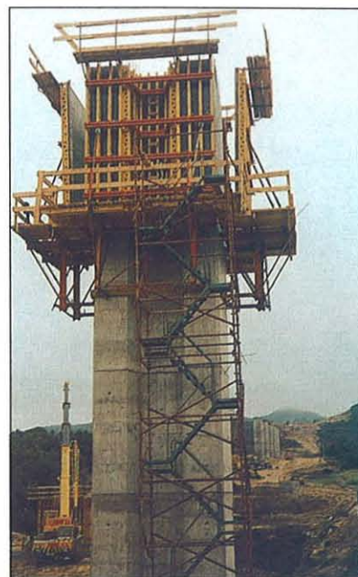
Las pilas se han realizado mediante encofrado trepante.
