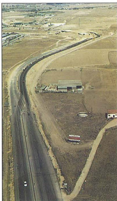
Vista parcial del tramo en la fase de construcción.
