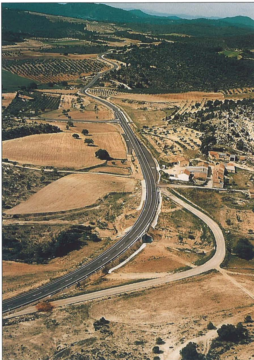
La obra fue dividida en dos tramos bien diferenciados para su acondicionamiento. En total, más de 29 km.
