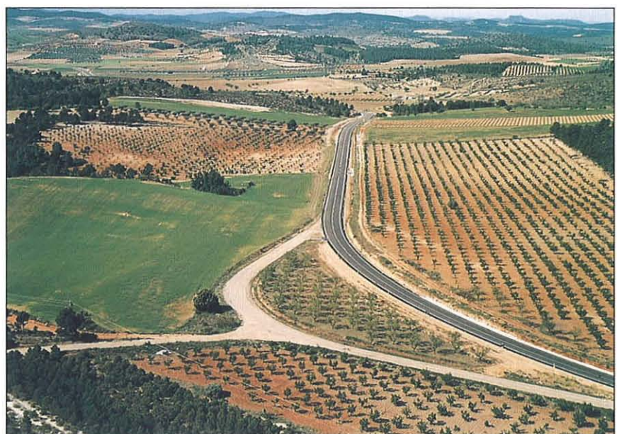
La calzada en todo el itinerario es de 7 m, con un carril de 3,5 m en cada sentido de la circulación.
