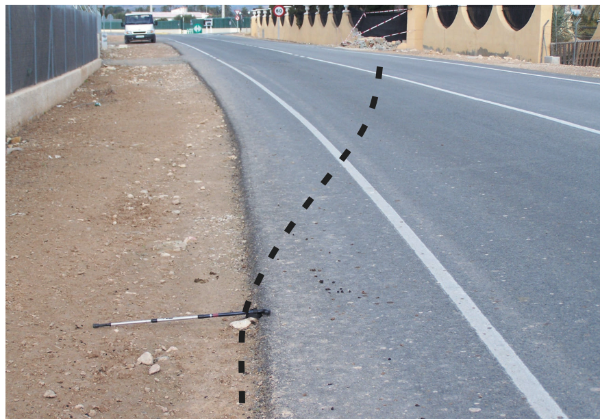
La línea muestra la trayectoria de las ruedas del lado izquierdo desde la berma izquierda hacia la berma derecha donde impactó con el obstáculo de la página 25, rotando hacia la izquierda, lo que hizo que impactara frontalmente con el muro.
