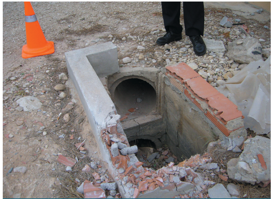
Antes, la rueda delantera derecha de su coche impactó contra este obstáculo en la berma derecha, el coche rotó por la acción del obstáculo yéndose de frente contra el muro sin poder hacer nada por evitarlo.
