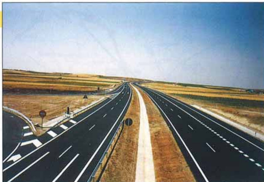
La plataforma se compone de 2 calzadas, con dos carriles de 3,50 m cada una, en cada sentido de la circulación.
