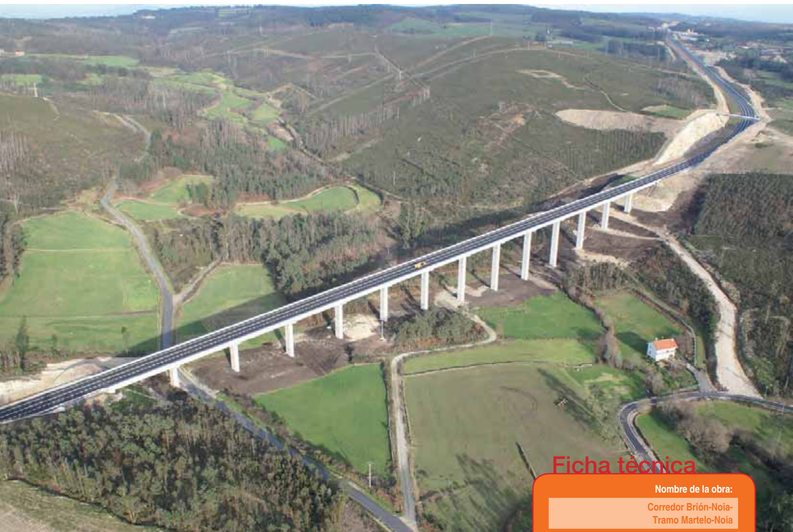
Vista aérea del viaducto de Pasares, de 475 m de longitud. Se trata de un puente de vigas con 14 vanos isostáticos, de 34 m de luz
