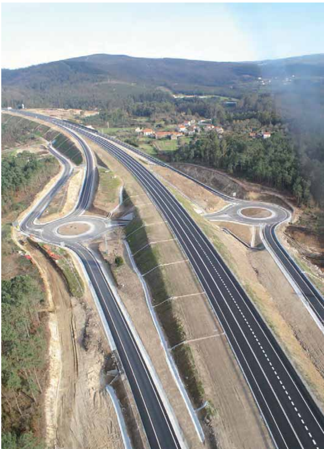
A lo largo del tramo Martelo-Noia se han dispuesto los enlaces de Sampaio de tipo diamante con pesas, y Pontenafonso, también de tipo diamante, pero con glorieta a distinto nivel
