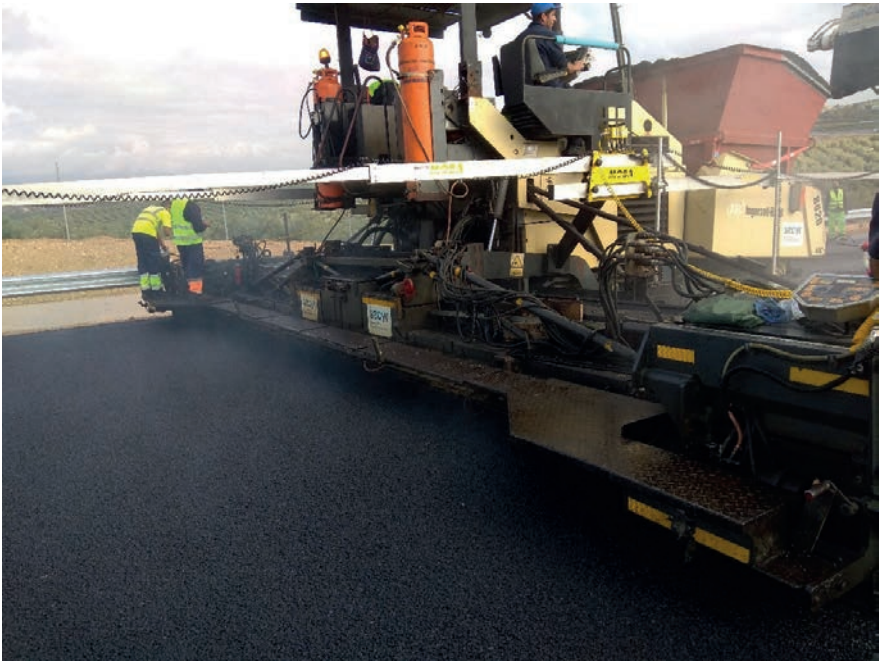
Figura 1. Extendido de la mezcla BBTM 11 B 35/50+RARX
