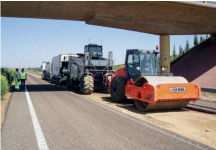
Figura 7. Reutilización in situ con cemento
