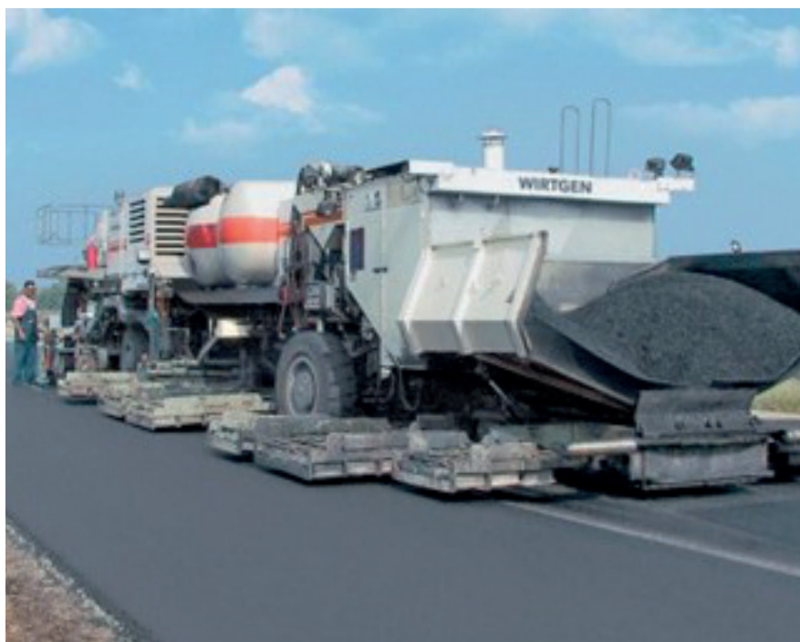
Figura 6. Reutilización en caliente in situ
