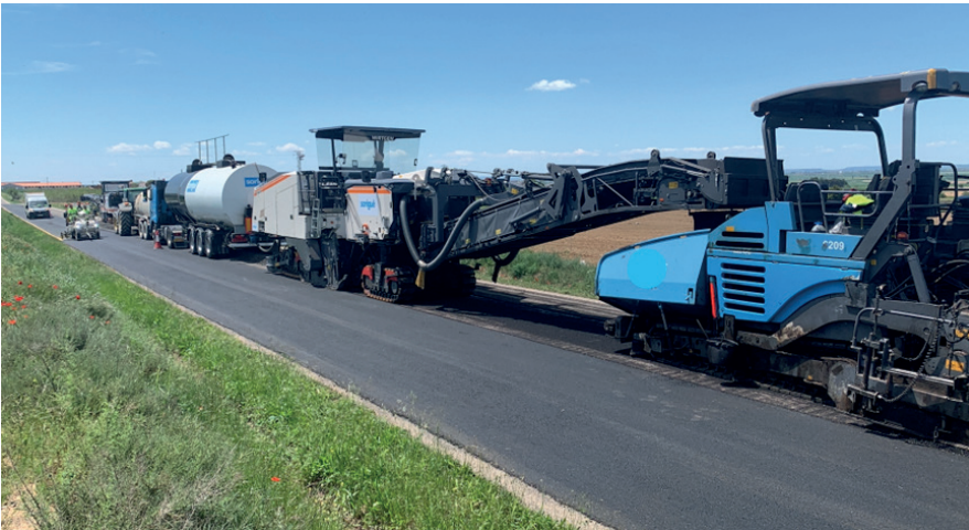
Figura 9. Reutilización in situ en frío con emulsión
