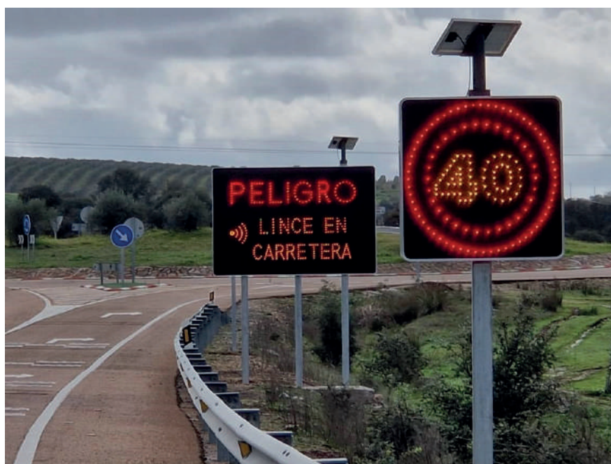
Figura 25. Sistema de detección de fauna salvaje
