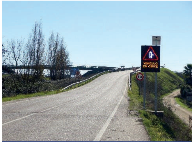
Figura 21. Señal inteligente en intersección, EX-106 Cruce Ruecas
