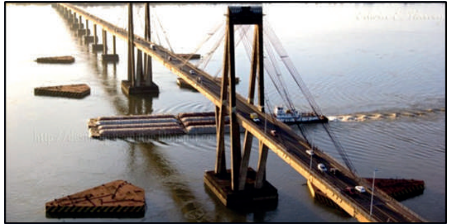
Figura 4. Vista del puente existente en operación
