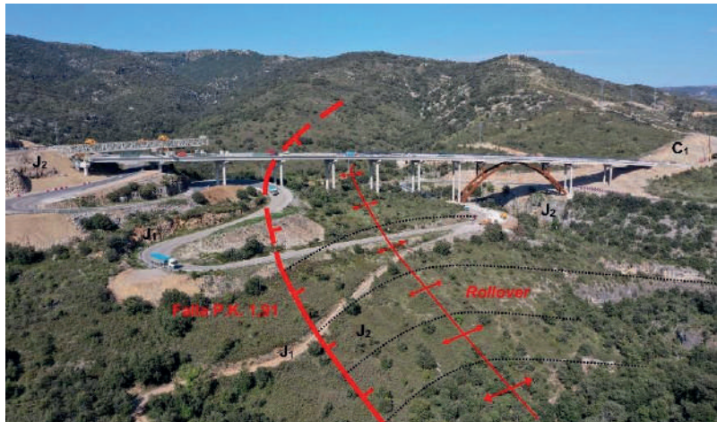
Figura 10. Panorámica de plegamiento rollover en el Barranco de la Bota asociado al labio hundido de la Falla P.K. 1,91 (Mayo 2022)
