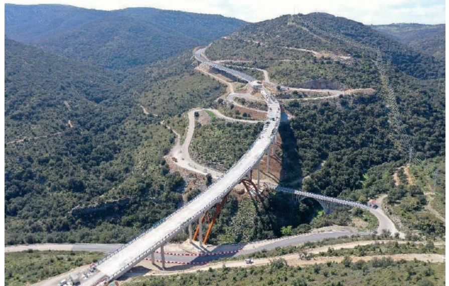
Figura 1. Panorámica de la carretera en construcción y de la antigua N-232 desde el viaducto del Barranco de la Bota hacia la subida al Puerto de Querol (Mayo 2022)
