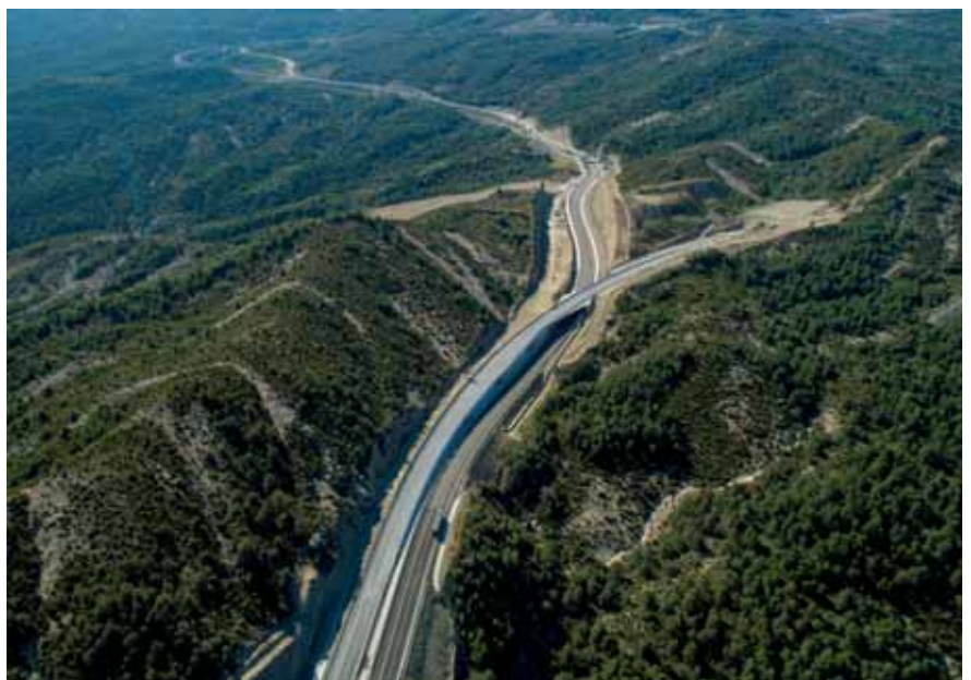
Figura 1. Autovía A-23. Tramo: Alto de Monrepós - Caldearenas. Separación entre ambas calzadas
