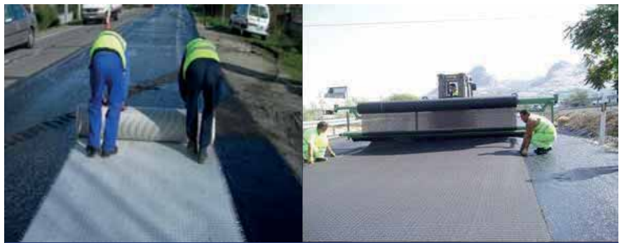
Figura 8. Extendido manual y mecánico
