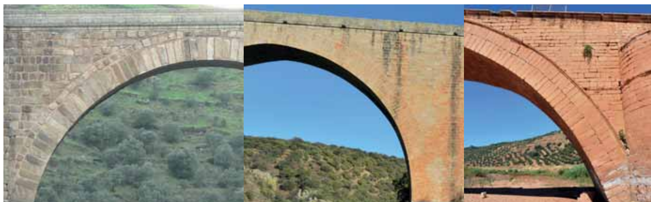
Figura 10. Detalles de doble rosca de los puentes de Alcántara, Almaraz y Ariza
