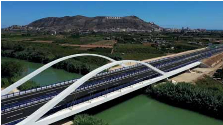
Figura 3. Autovía A-38. Tramo Cullera-Favara. Viaducto del Jucar
