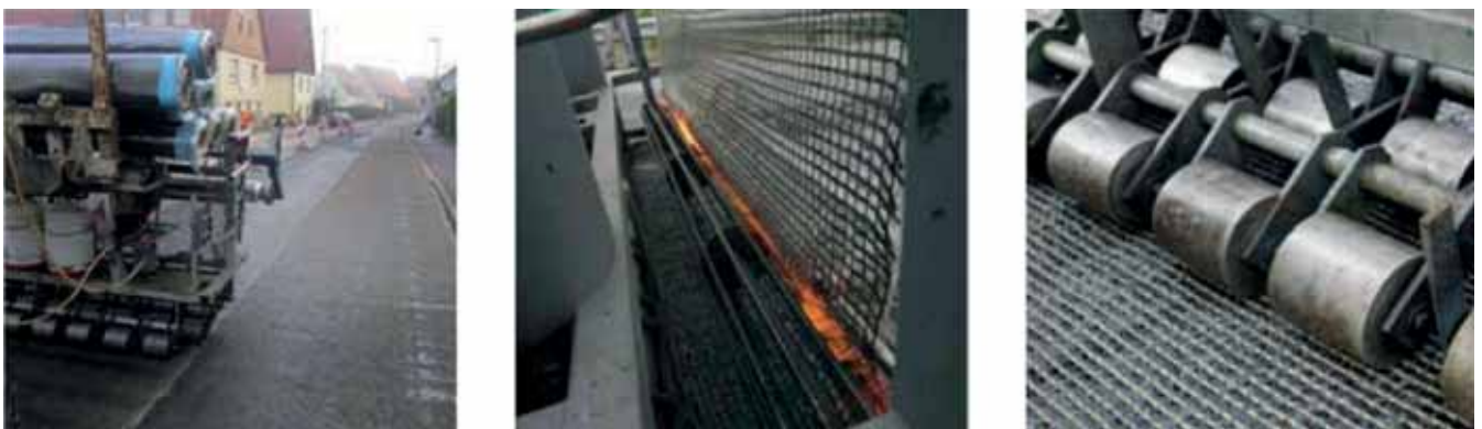
Figura 9. Extendido mecánico, Calentamiento del betún y compactado con rodillos
