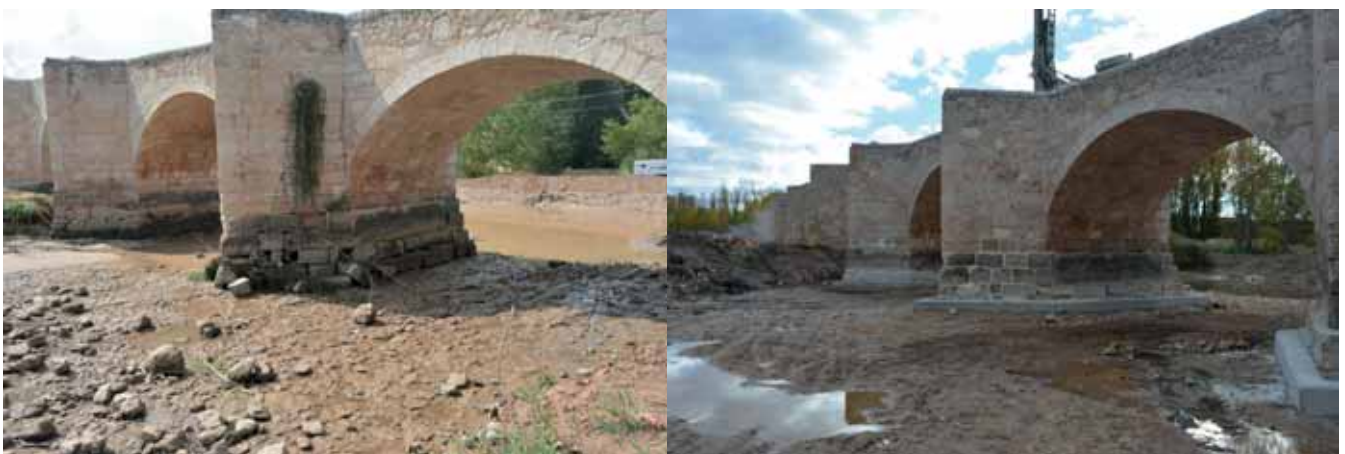
Figura 14. Estados inmediatamente anterior y posterior a la reparación de una pila en el puente de Langa de Duero. Foto del equipo en una visita del curso 2020-21
