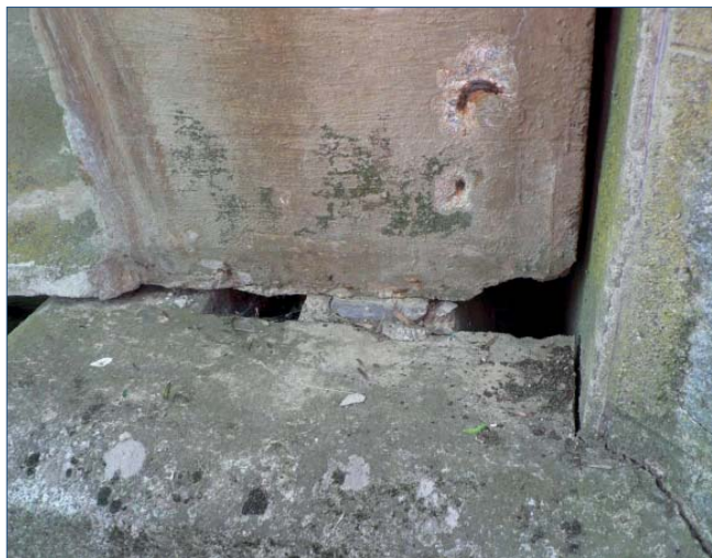
Figura 16. Giro del tablero en lado derecho de E-2. Apoyo sobre péndulo
