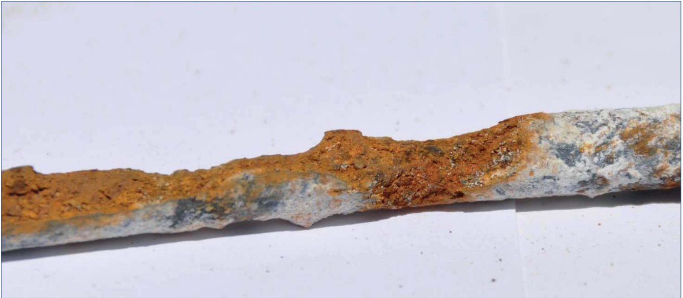
Figura 33. Estribo de armadura pasiva con picaduras de corrosión (ubicación desconocida)
