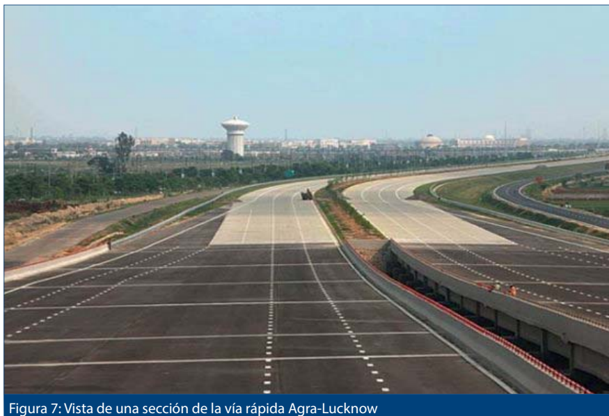
Figura 7: Vista de una sección de la vía rápida Agra-Lucknow
