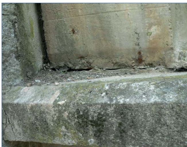
Figura 15. Giro del tablero en lado derecho de E-1
