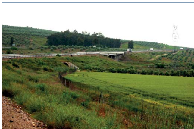
Figura 2. Ejemplo de caso RVA. Autovía A-2, p.k. 340
