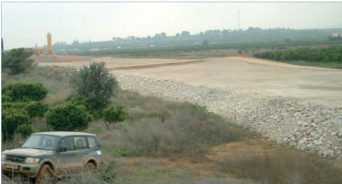
Figura 12. Caso RIB. Cimiento realizado con pedraplén (A21). Línea de Alta Velocidad Picassent- Alcásser
