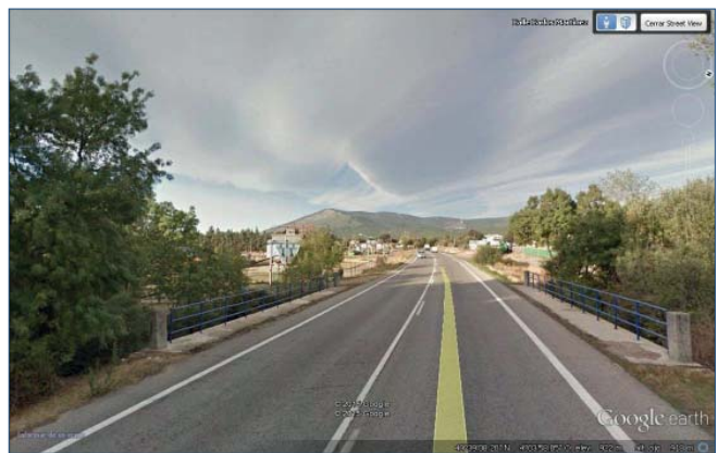
Figura 3. Vista de la estructura en sentido creciente de los PK hacia el oeste (Google Earth) pocos meses antes del colapso
