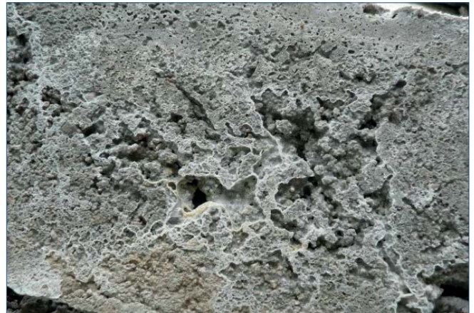
Figura 22. Torta de mortero interpuesta entre dovelas. Gran porosidad y depósitos calcáreos
