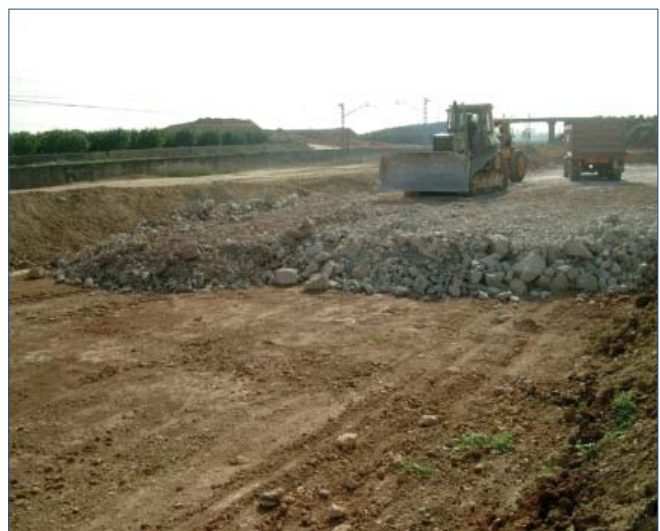
Figura 11. Caso RIB. Relleno de saneo con pedraplén (B11). Línea de Alta Velocidad Picassent- Alcásser
