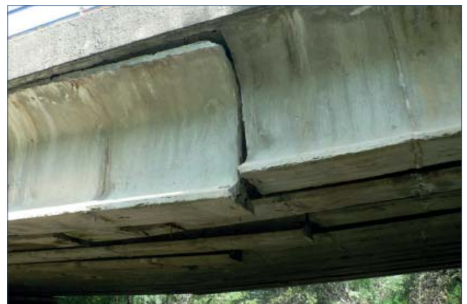
Figura 12. Vista de la viga 1 (lado izquierdo) a las 11:55, aprox., del 29 de mayo de 2015. Se aprecian las juntas entre dovelas
