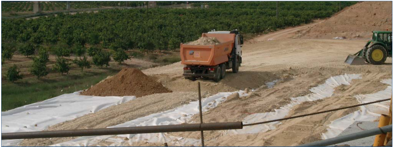
Figura 13. Caso RIB. Geotextil entre el pedraplén del cemento y el relleno superior (D11). Línea de Alta Velocidad Picassent- Alcásser
