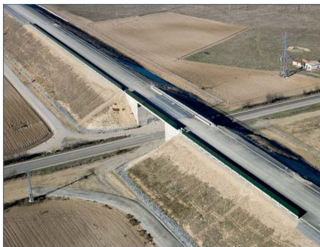
Figura 3. Ejemplo de caso RIB. Línea de Alta Velocidad Pozal - Villaverde. Puede apreciarse la protección de escollera en pie del relleno
