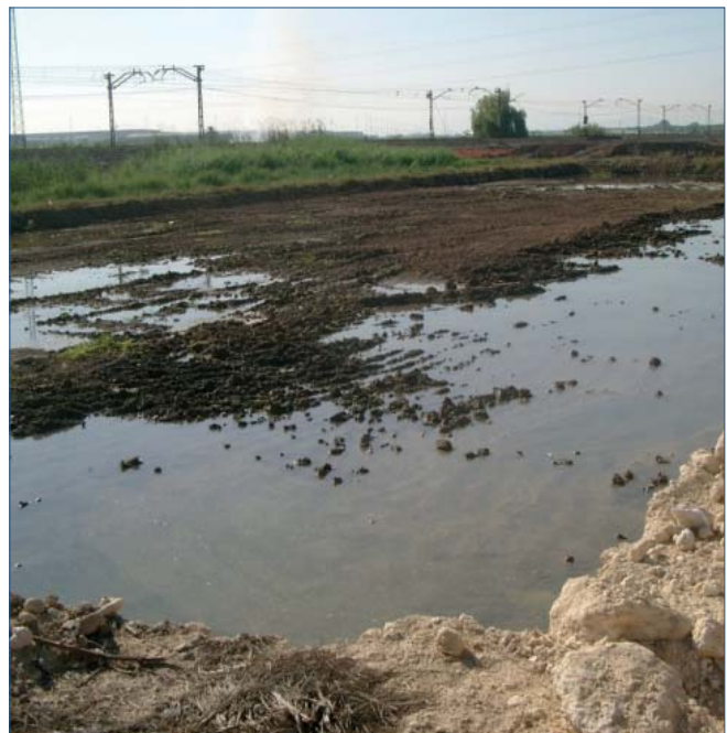
Figura 10. Caso RIB. Saneo en terreno de apoyo (B1) en zona con nivel freático alto. Línea de Alta Velocidad Picassent- Alcásser
