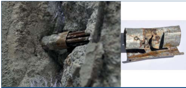
Figura 23. Manguito de hojalata en la transición entre dovelas
