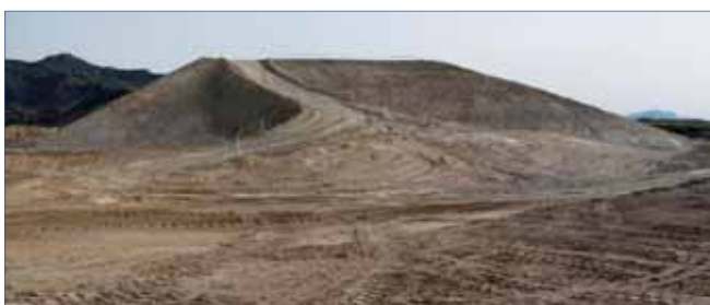
Figura 5. Panorámica del terraplén de prueba
