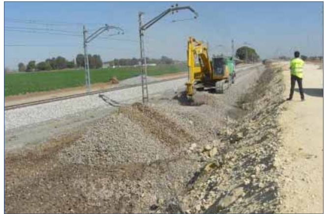
Figura 15. Retirada del balasto de la vía antigua
