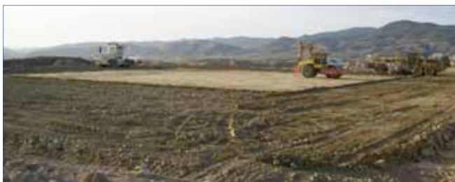
Figura 4. Fase inicial de construcción del terraplén experimental
