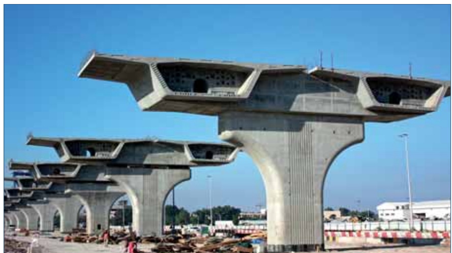
Figura 3. Pilas y diafragmas del viaducto principal (pila integral en primer plano)
