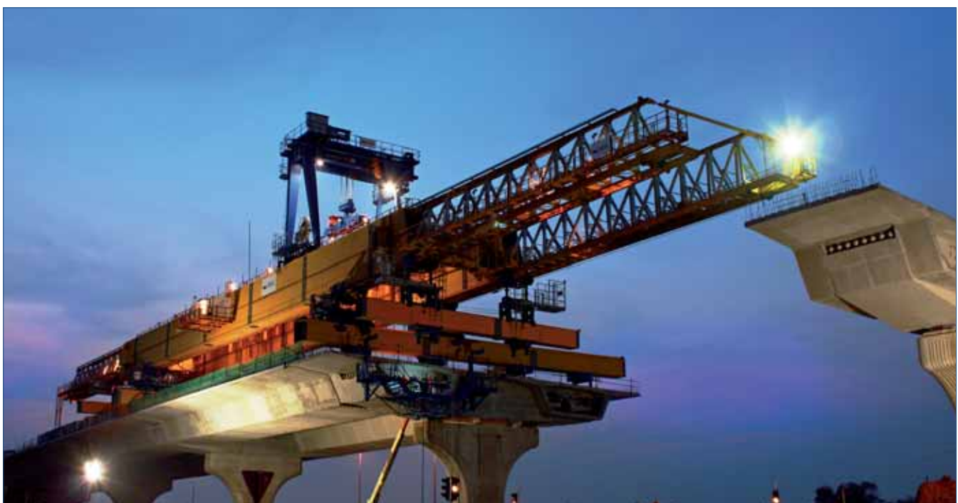
Figura 9. Viga de lanzamiento
