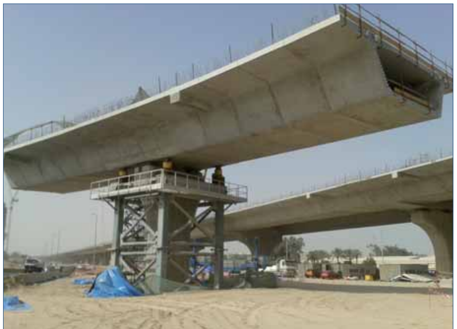
Figura 6. Construcción por avance en voladizo en los ramales
