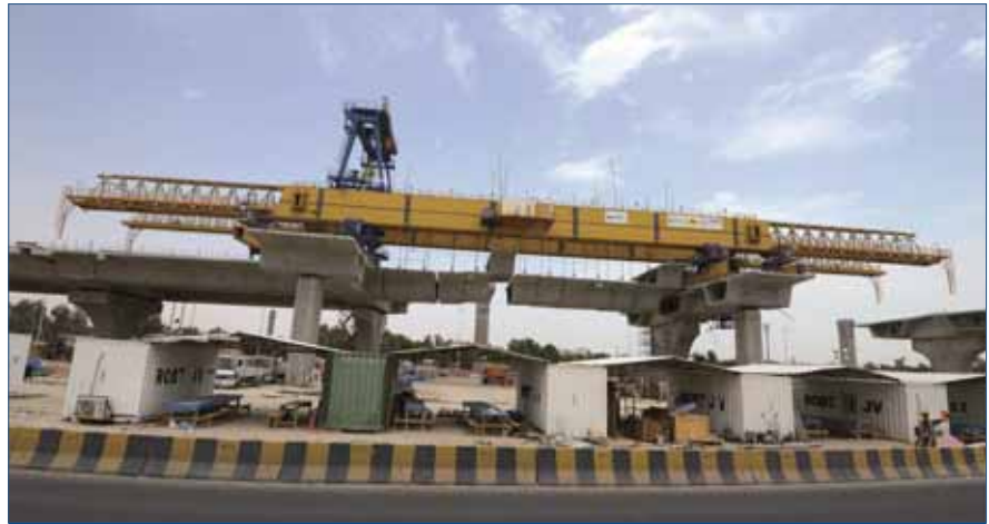
Figura 2. Construcción vano a vano
