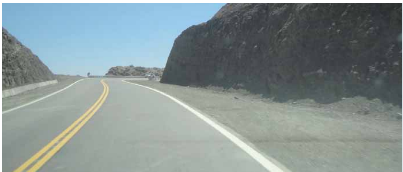
Figura 12. Vista hacia progresivas decrecientes del macizo reperfilado de progresiva 16 700
