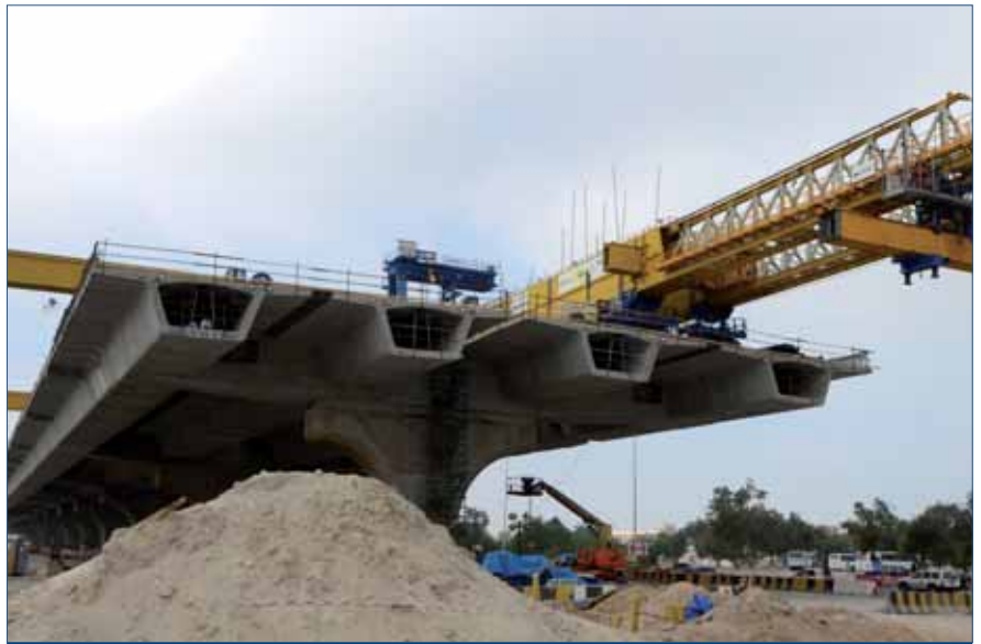
Figura 5. Tablero en vano con 4 cajones en paralelo
