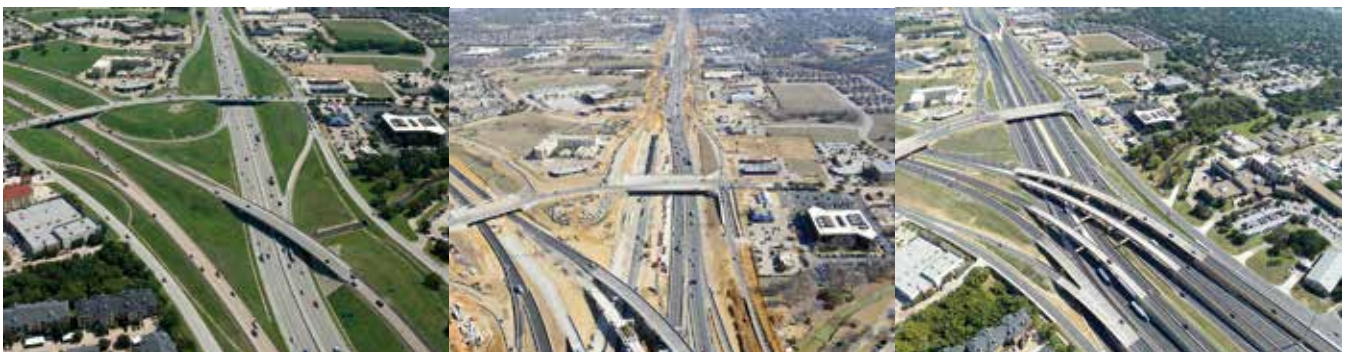
Proceso constructivo 121 split
