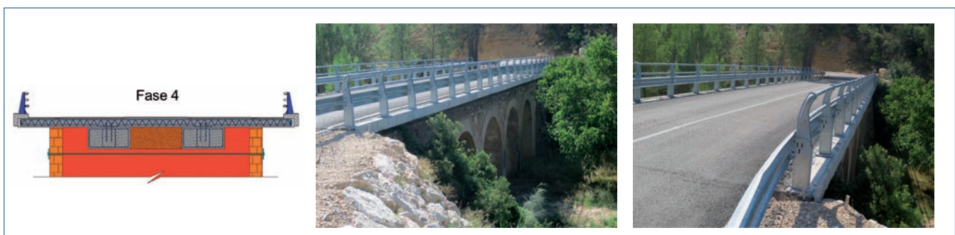
Figura 13. Actuación en Fase 4, pavimentación y acabados.
