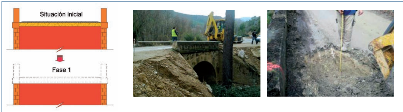
Figura 10. Actuación en Fase 1 de demolición de pretilas y paquete de firme.
