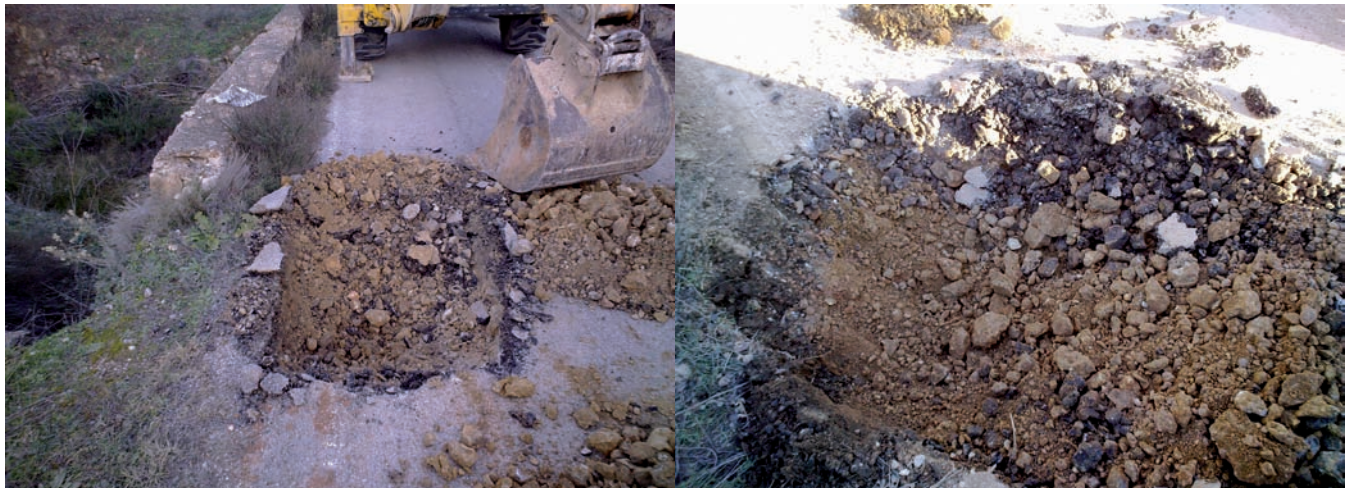
Figura 2. Realización de catas para la determinación de espesores de firme y relleno.
