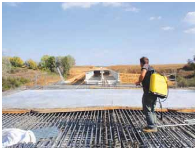
Figura 28. Construcción y curado de la losa de compresión.
