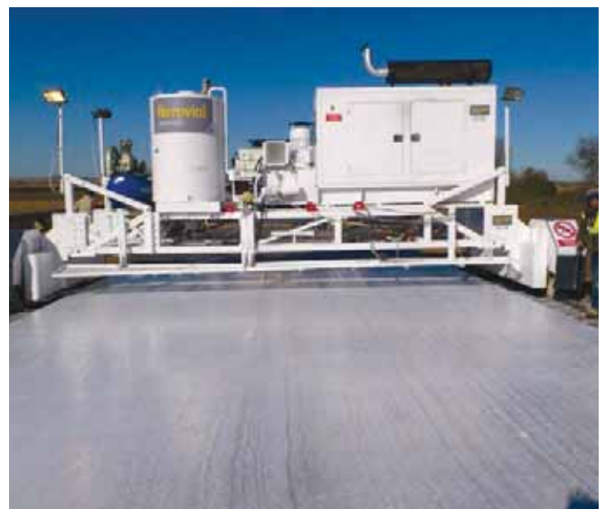
Figura 8. Carro de curado.
