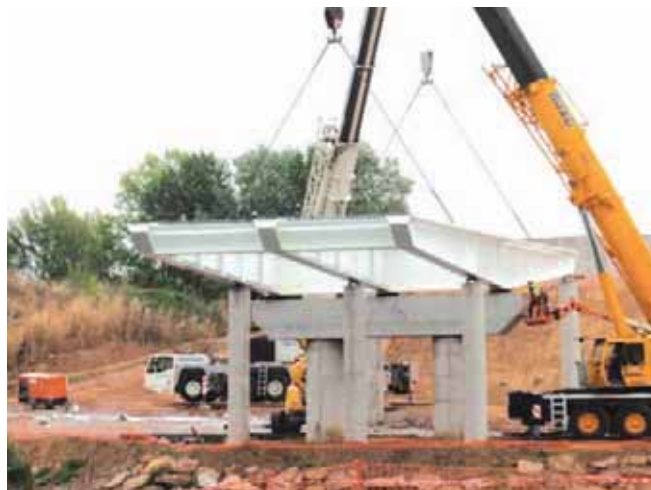
Figura 26. Montaje de dinteles en el tramo sobre el río Esla.
