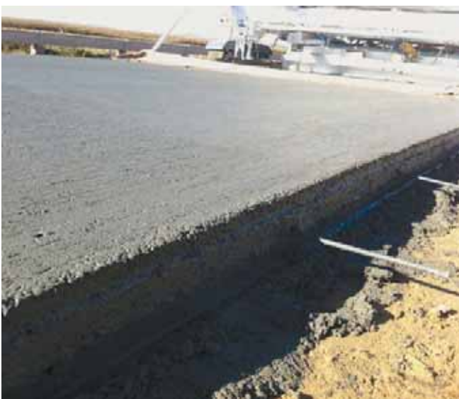
Figura 7. Barras de atado con el arcén.
