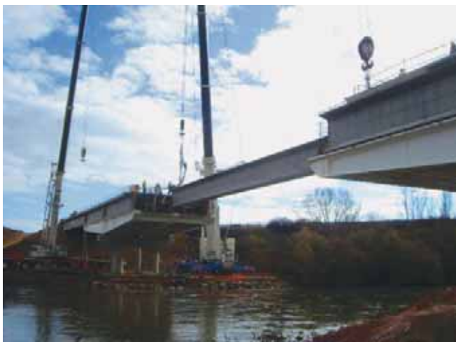
Figura 27. Montaje de vigas.
