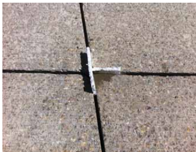
Figura 20. Reparación de junta rota tras el fresado con resina epoxídica.
