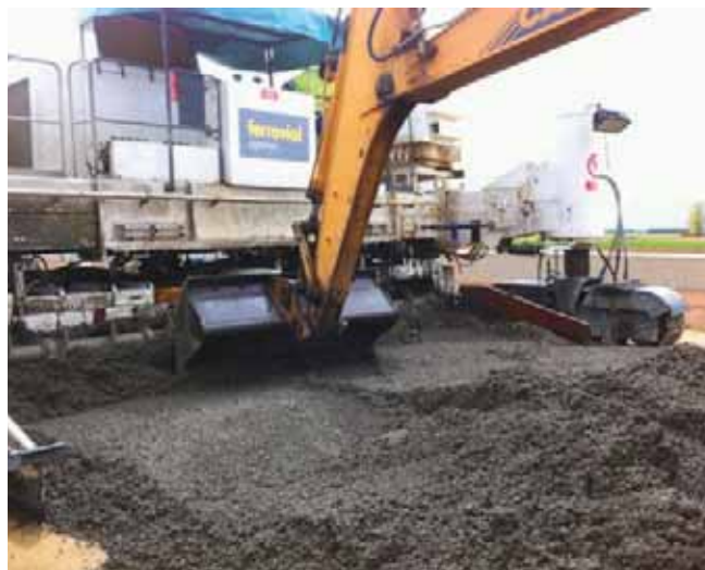
Figura 4. Pre-extendido del hormigón.
