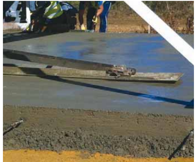
Figura 6. Parte trasera de la extendidora tras la arpillera y la bailarina.
