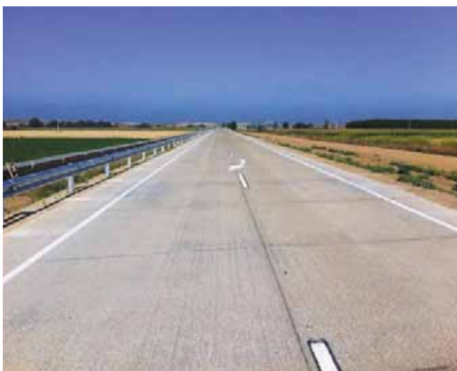
Figura 23. Perspectiva del pavimento de hormigón microfresado.
