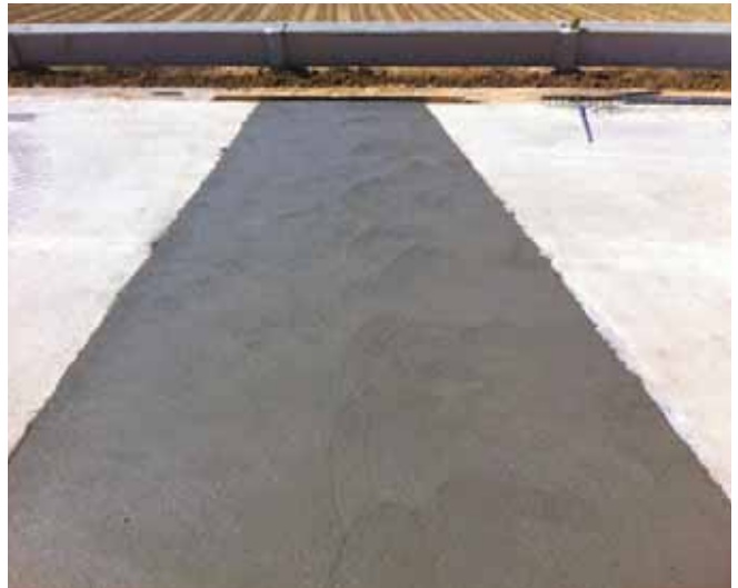
Figura 22. Reparación de una grieta aparecida en el pavimento antes de microfresar (2).
