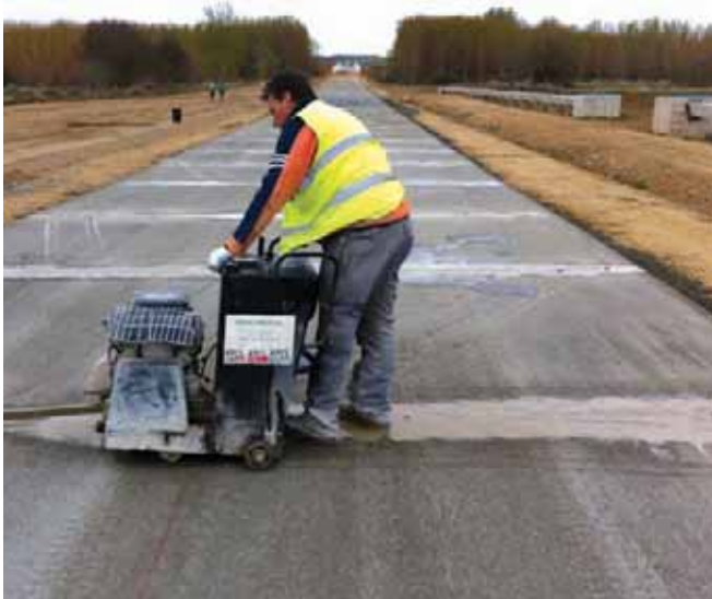
Figura 11. Serrado de juntas.
