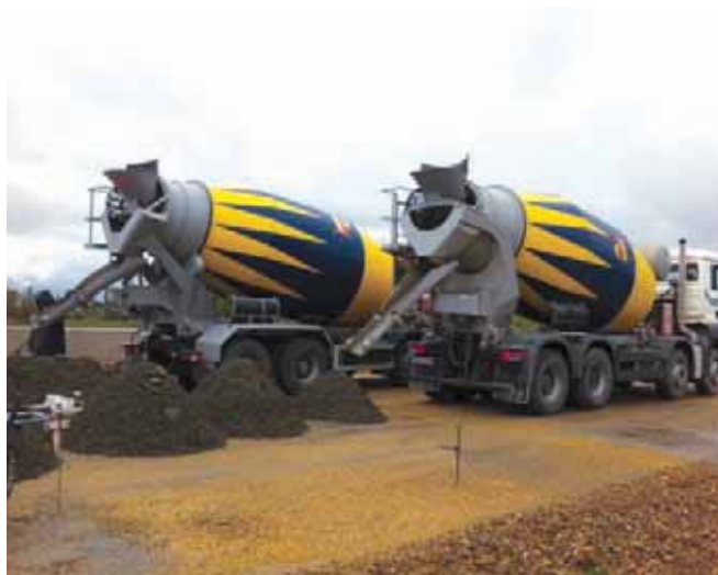
Figura 3. Transporte del hormigón.
