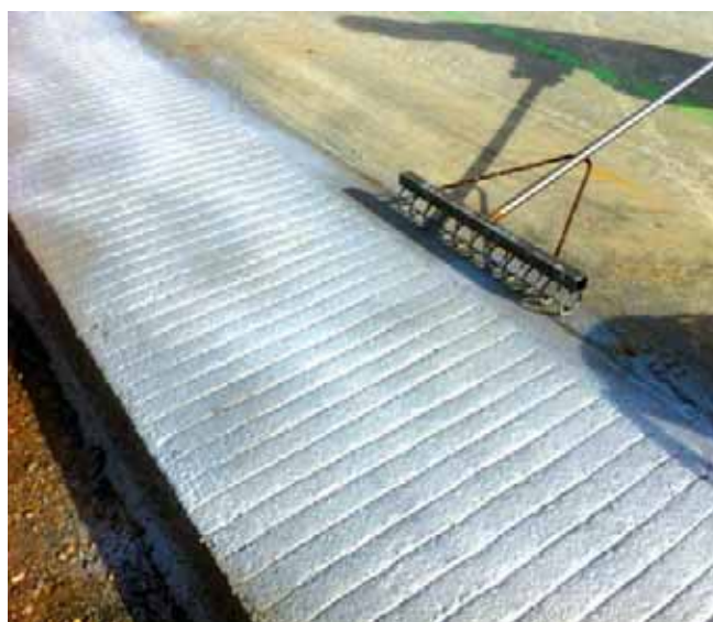
Figura 10. Rayado del arcén de 0,75 m de ancho.
