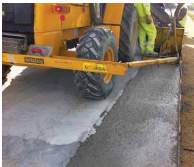
Figura 9. Extendido del arcén de 0,75 m de ancho.
