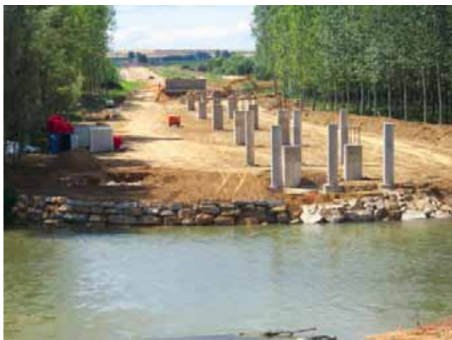
Figura 25. Pilas del segundo tramo del viaducto.
