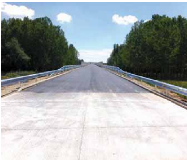
Figura 12. Cambio de sección rígida a flexible en el acceso al puente.
