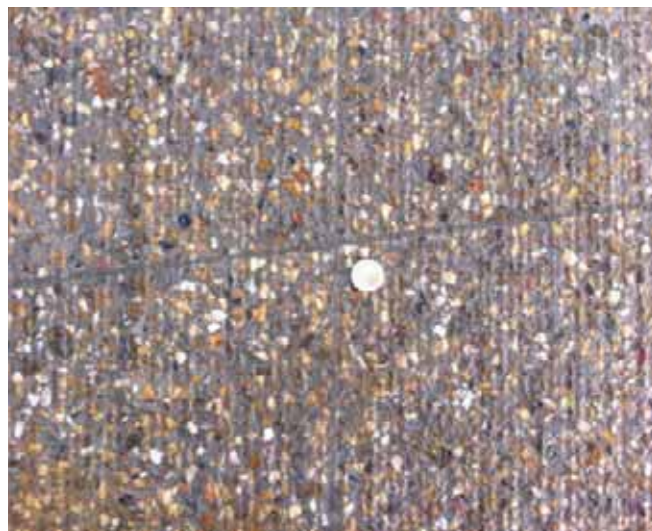
Figura 18. Detalle de junta fresada con mortero previo de protección.
