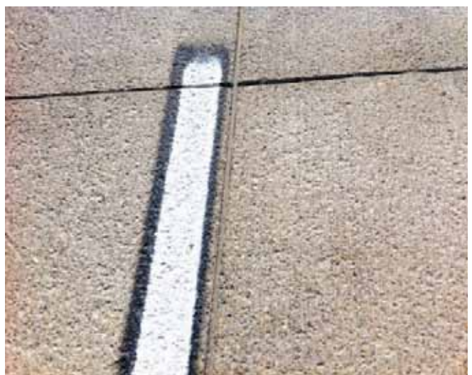
Figura 24. Detalle del pavimento de hormigón microfresado.
