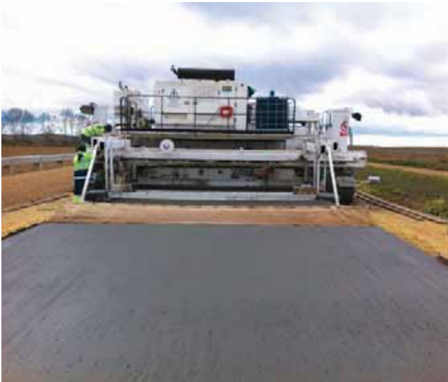
Figura 5. Extendido del hormigón.
