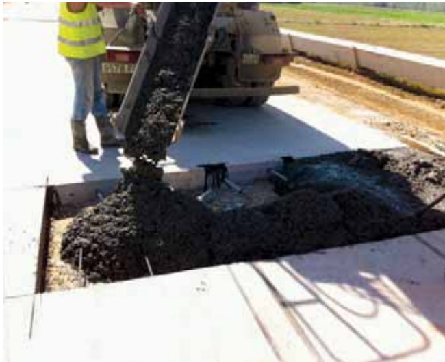
Figura 21. Reparación de una grieta aparecida en el pavimento antes de microfresar (1).
