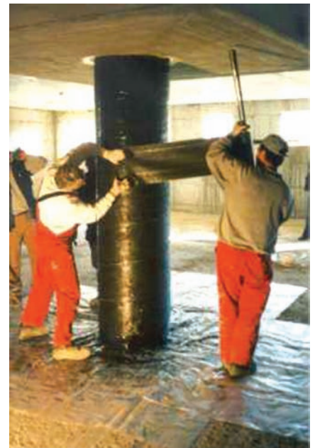
Figura 4. Confinamiento de un pilar.
