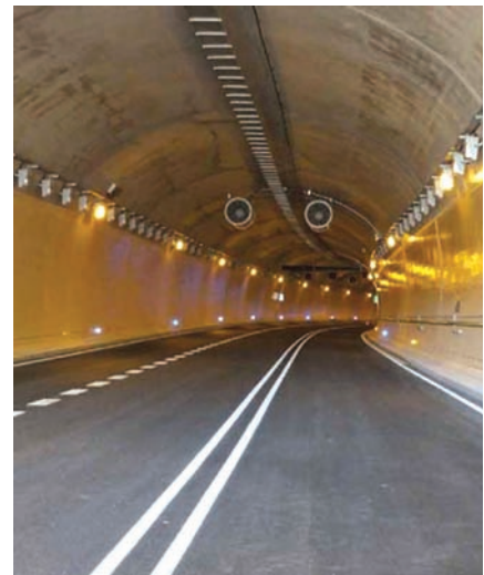
Figura 13. Túnel de Petralba N-260 (VSAP).
