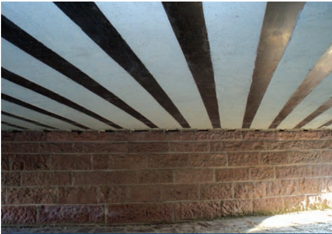
Figura 2. Ejemplo de refuerzo con materiales compuestos.
