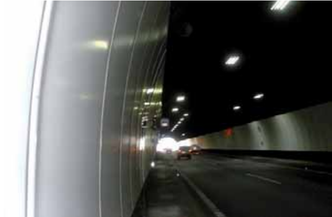
Figura 5. Vista interior de los Túneles de Parpers
