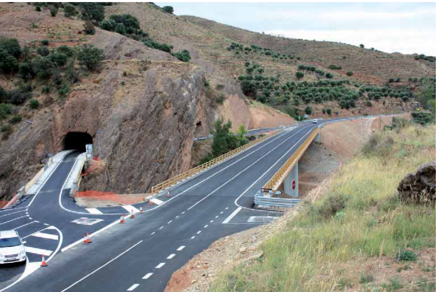
Otra de las obras destacadas de esta Consejería es la reciente construcción del nuevo puente de Arnedillo
