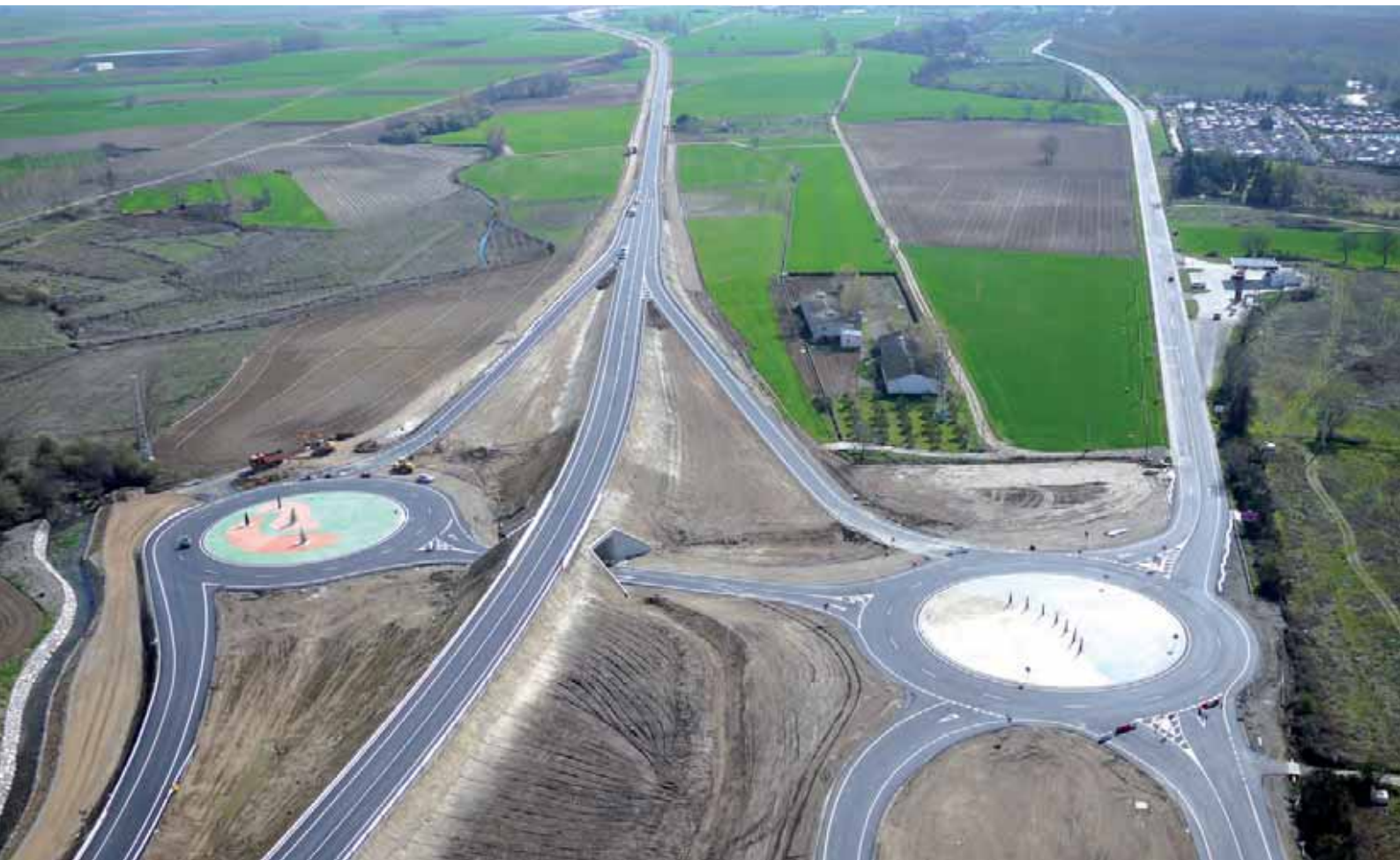
A lo largo del tramo se han dispuesto 3 enlaces a distinto nivel. La imagen corresponde al enlace de Casalarreina
