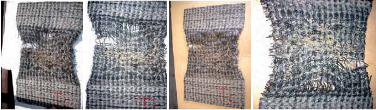
Figura 14. Estado de las probetas de GBR-C, una vez rotas. Se aprecia el deterioro completo de los geotextiles, tejidos y no tejidos, así como la salida al exterior de la bentonita
