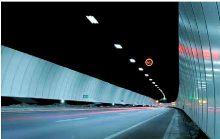
Figura 2. Vista interior de los Túneles de Parpers
