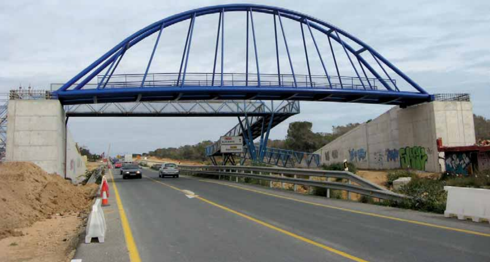
Sustitución de pasarela peatonal
