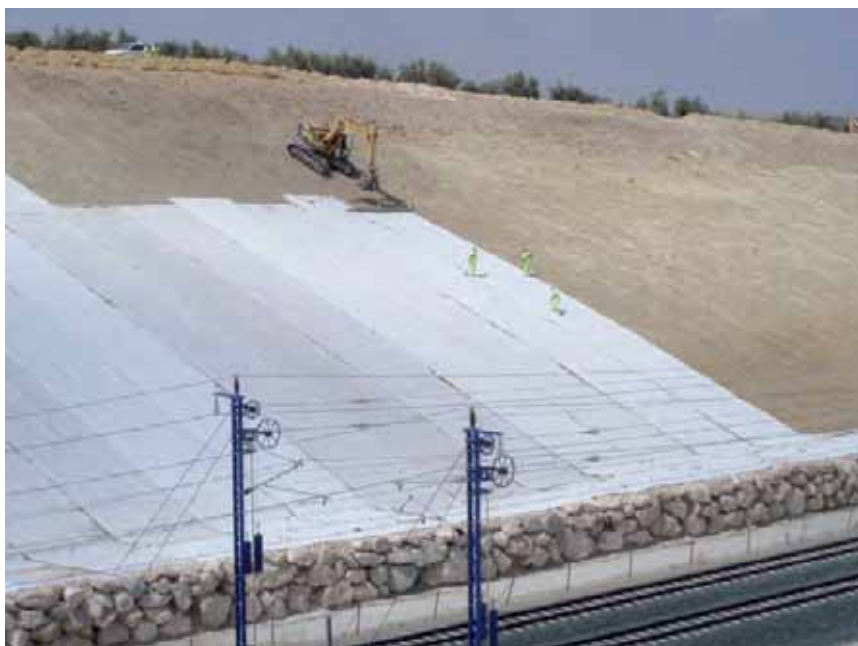
Figura 3. Instalación de barreras geosintéticas arcillosas en un talud
