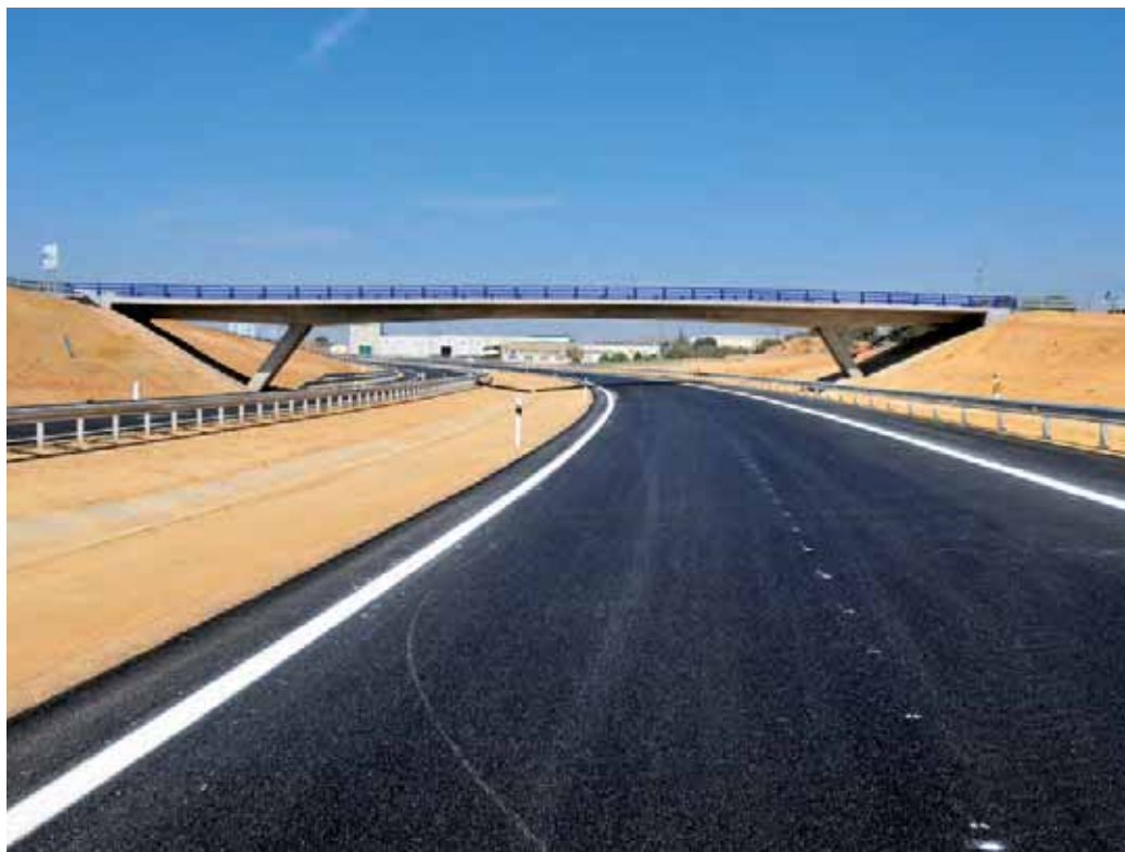
Pórtico de células triangulares correspondiente al enlace Binéfar Oeste
