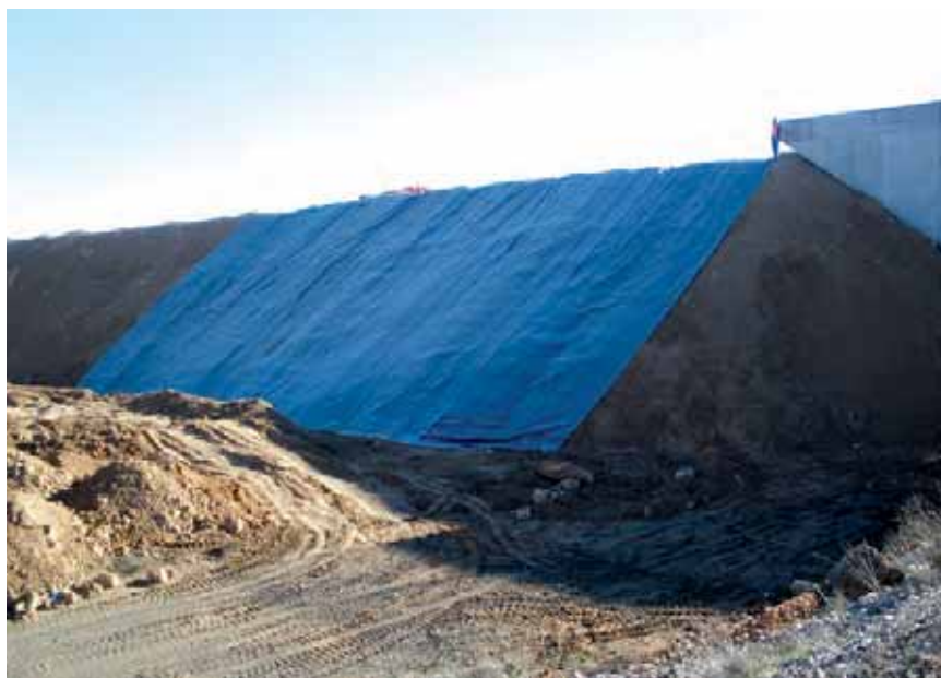
Figura 6. Detalle de la impermeabilización del talud de un paso a nivel en la localidad de Puebla de Hijar (Teruel)
