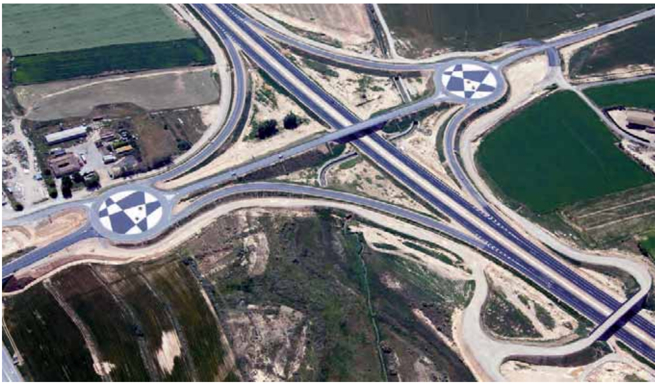
Enlace de La Melusa y paso superior reposición de Cañada Real
