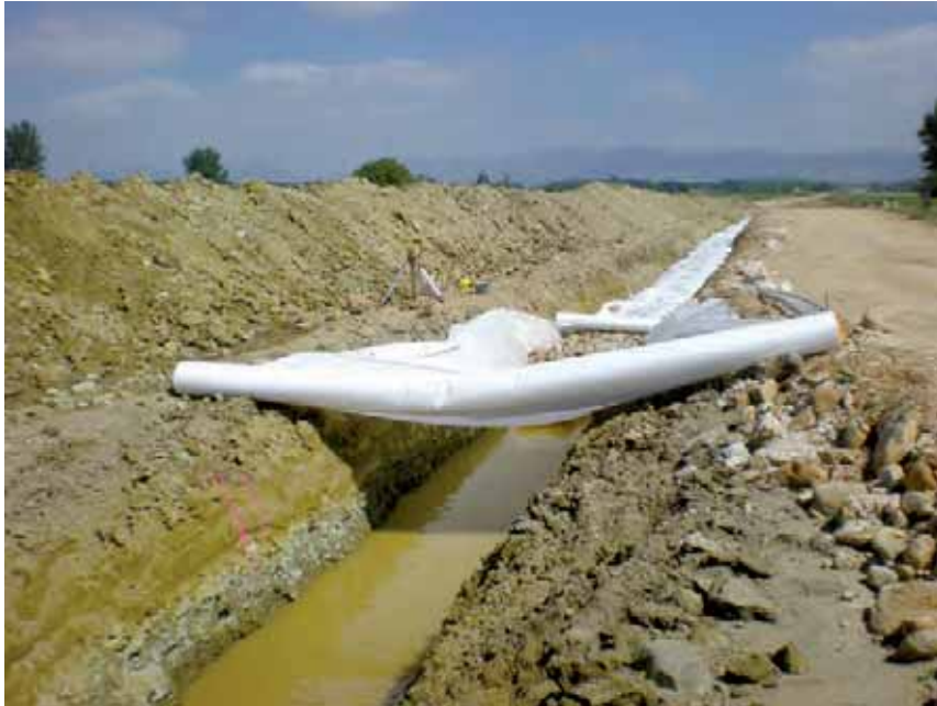
Debido a la proximidad del nivel freático, se tuvo que drenar el terreno sobre el que se asientan los terraplenes, desde el p.k. 2+600 hasta el final de la obra
