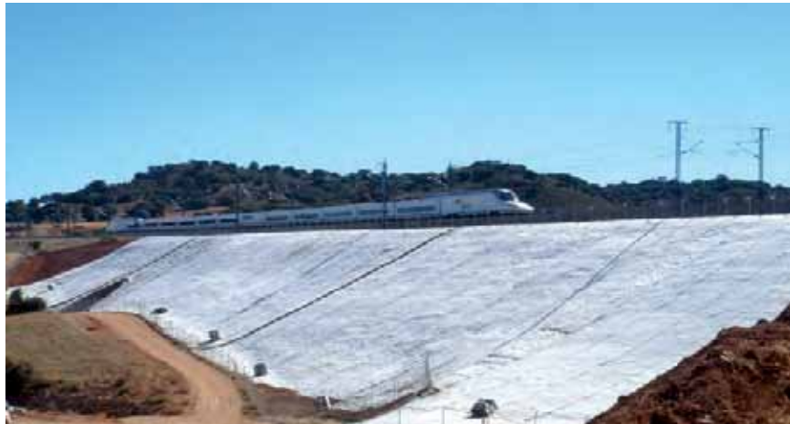
Figura 4. Barreras geosintéticas arcillosas en un talud
