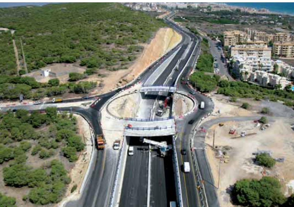
Enlace de Los Montesinos en fase de construcción
