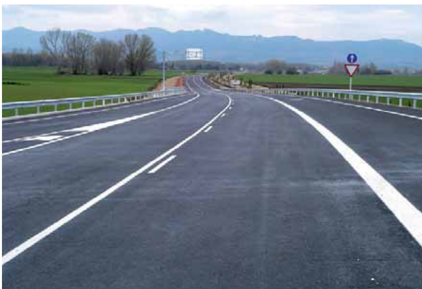
La sección transversal está formada por dos carriles de 3,5 m de anchura y arcenes de 1,5 m a cada lado
