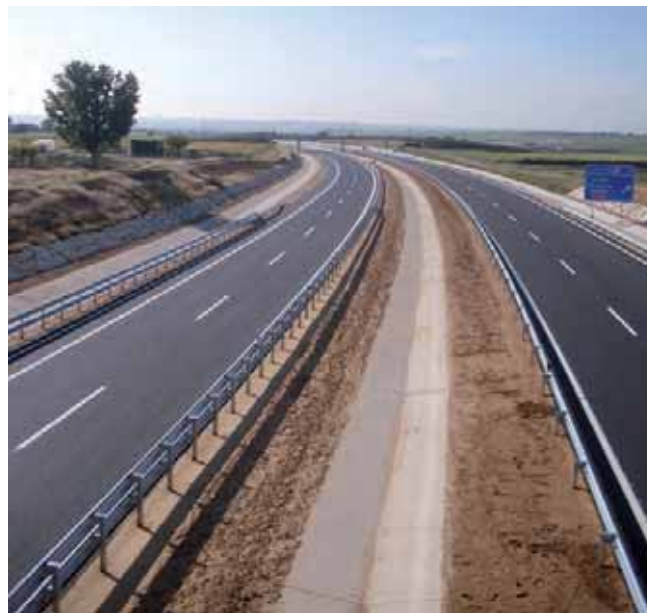
Sección transversal del tronco en desmonte
