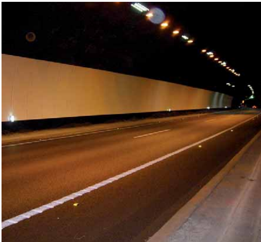
Figura 6. Vista interior de los Túneles de Parpers
