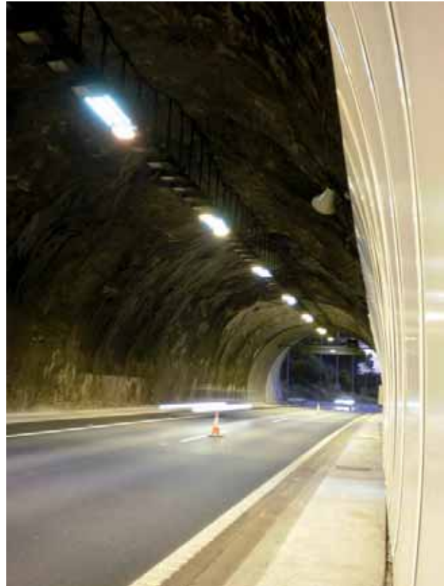
Figura 8. Vista interior de los Túneles de Parpers
