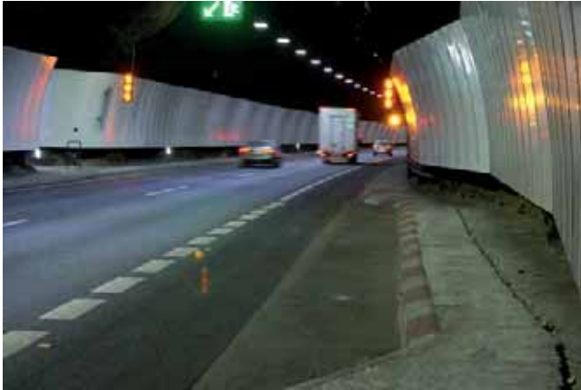
Figura 4. Vista interior de los Túneles de Parpers
