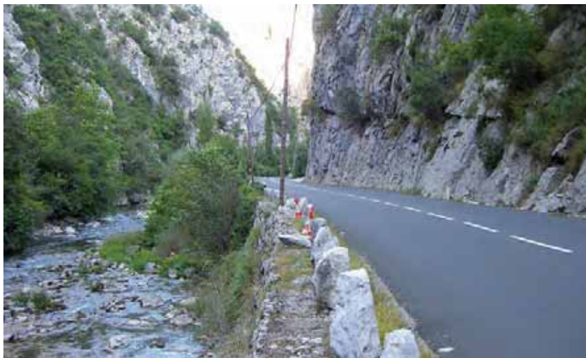
Figura 13. Tramo en el que previsiblemente será necesaria la ampliación mediante voladizo
