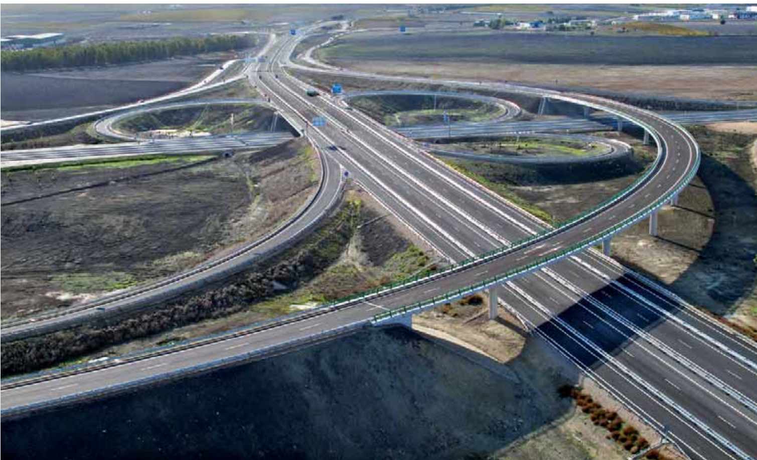
Vista panorámica del viaducto (estructura E3)
