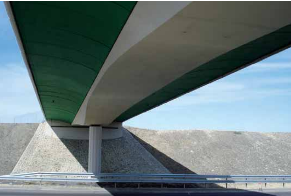
Detalle de la estructura E4
