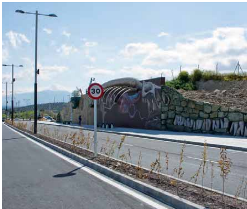
Distribuidor Norte de Jaén-El Lagarto de Jaén.
