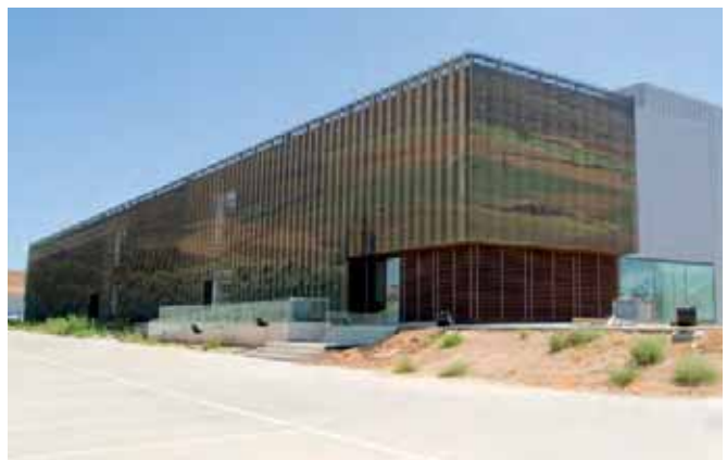
Fachada edificio Aceites Urzante
