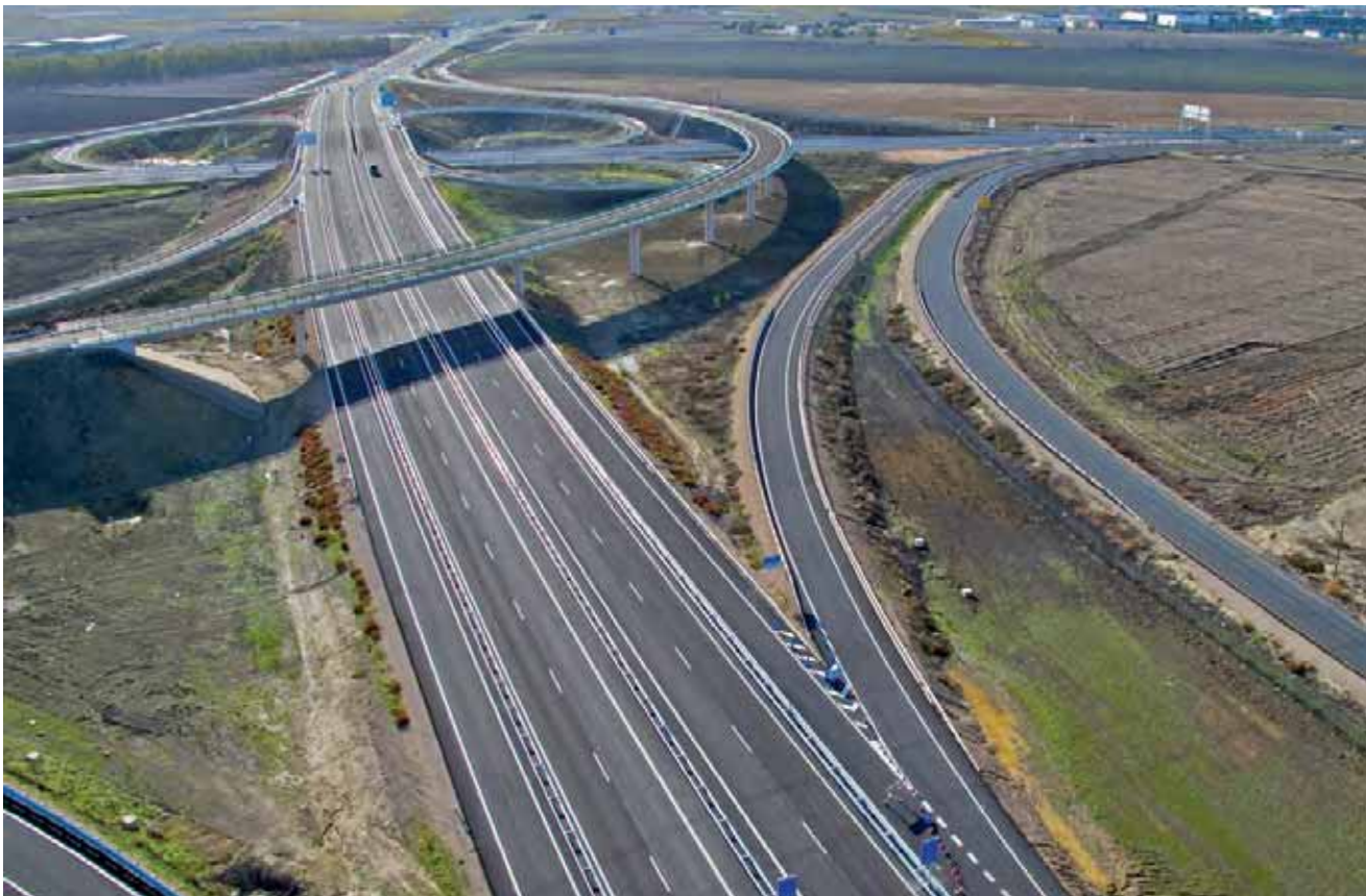
En la foto se aprecia la estructura E3 (viaducto)
