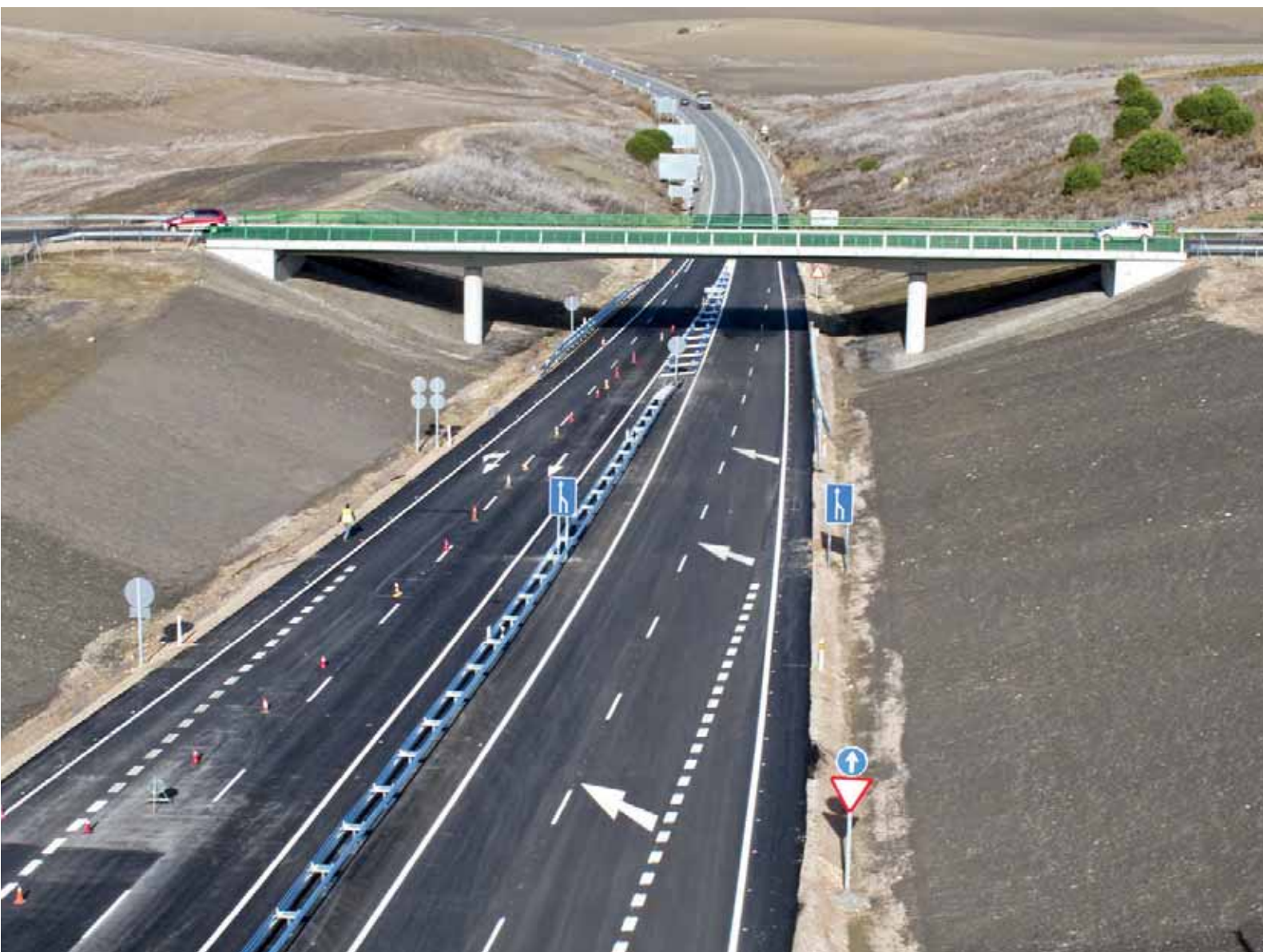
Estructura E4. Paso superior A-471
