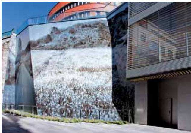
Fachada de la nueva ampliación del Ayuntamiento de Bilbao
