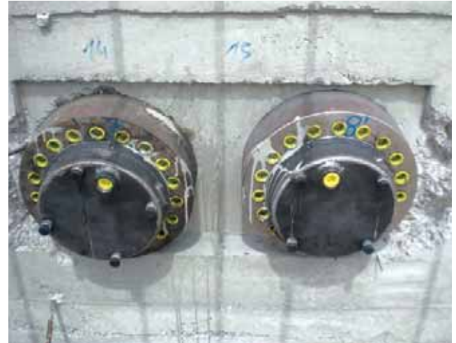
Acopladores del pretensado
