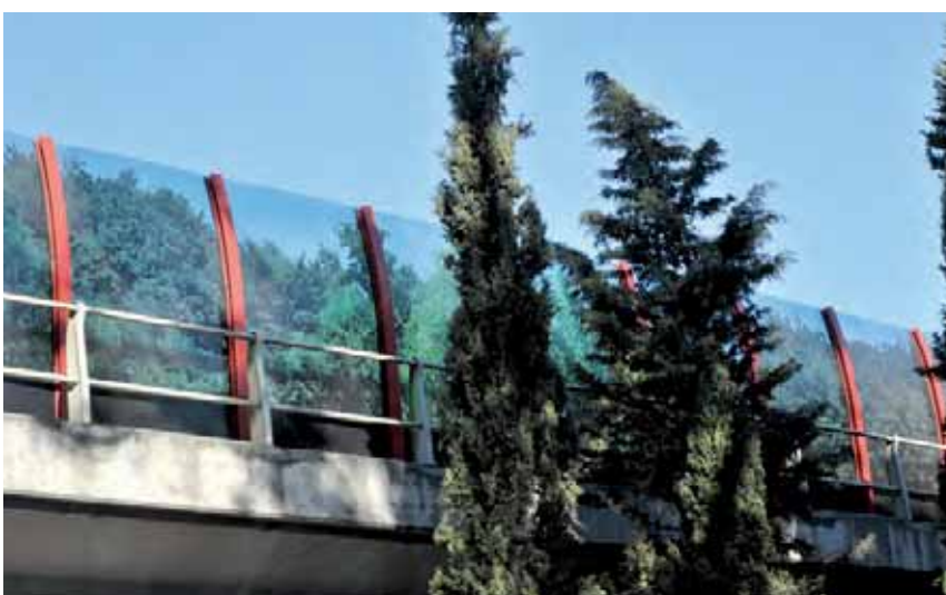
Pantallas acústicas en la A-8
