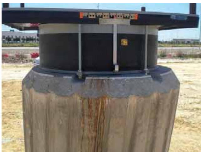
Detalle de apoyo deslizante en pilas
