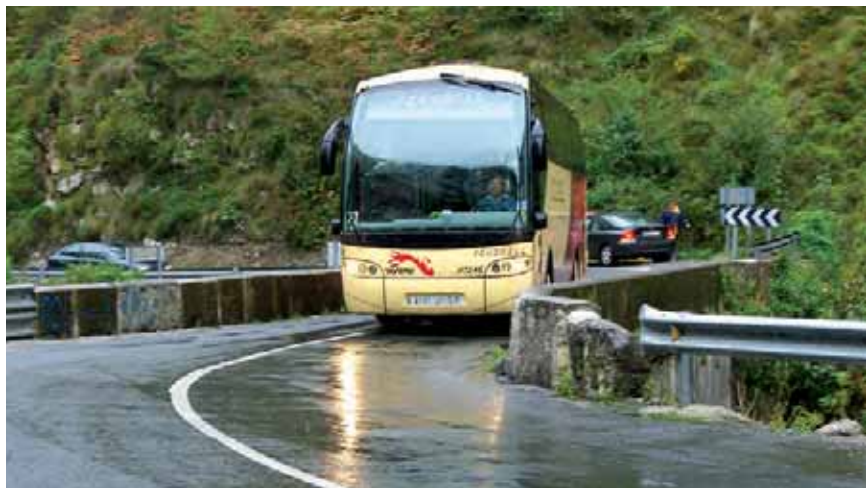
Figura 18. Los vehículos han de invadir el carril contrario para poder completar la maniobra de paso en los puentes
