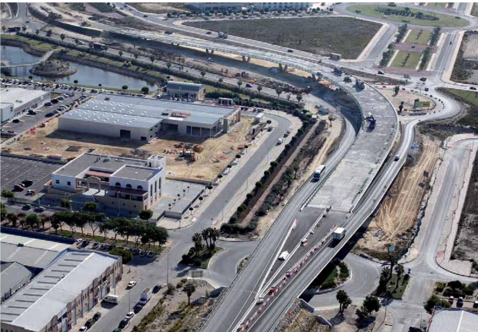
Vista parcial de la obra en su fase de construcción
