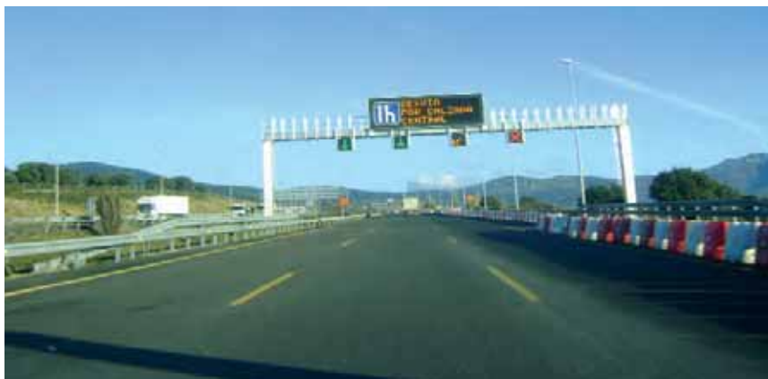
En la imagen se aprecia los accesos al túnel de Guadarrama
