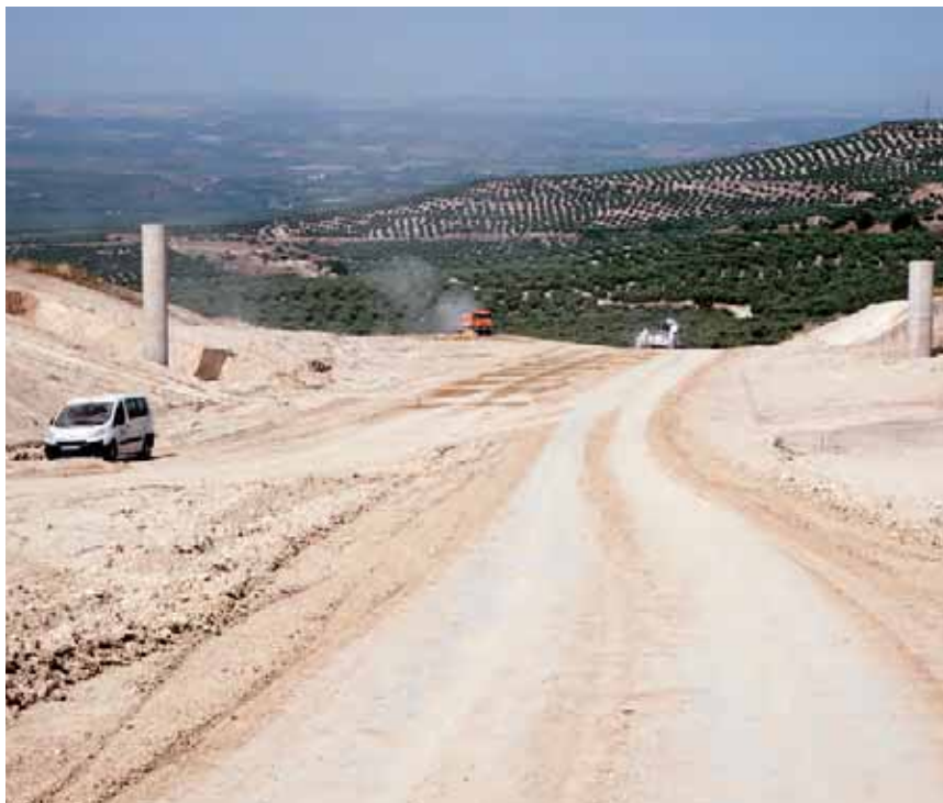
Tramo en obras de la Autovía del Olivar (A-318) en Jaén.
