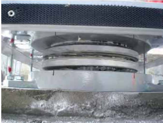
Detalle de apoyo esférico unidireccional
