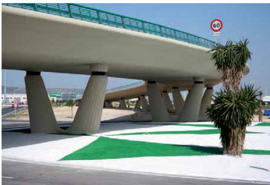
54 Vista inferior del viaducto donde se aprecia la esbeltez de la estructura y de sus pilas
