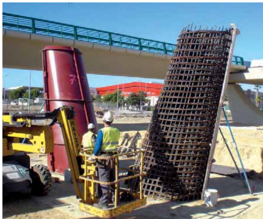
Detalle del encofrado y del acero en pilas
