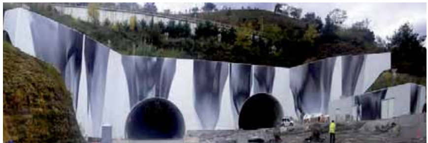
Revestimiento de las entradas a los túneles de Arraiz
