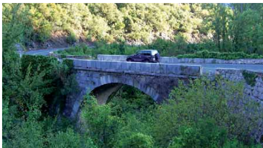
Figura 19. Puente sobre el río Deva junto a la intersección de acceso a Lebeña (p.k. 156,2)
