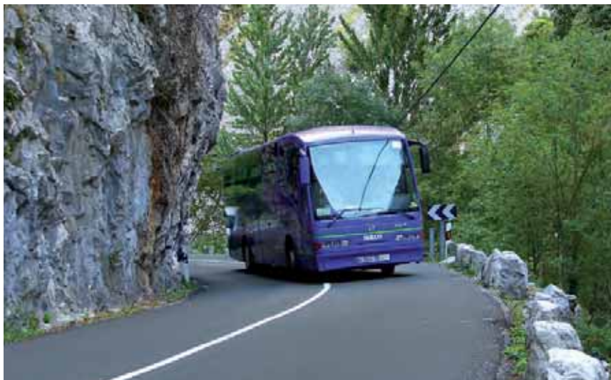
Figura 9. La invasión del carril contrario es frecuente en este tramo, con los consiguientes riesgos para la seguridad vial
