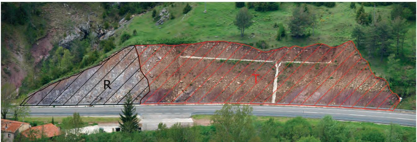
Figura 8. División del talud por consistencia. R: área roca y T: área tierras
