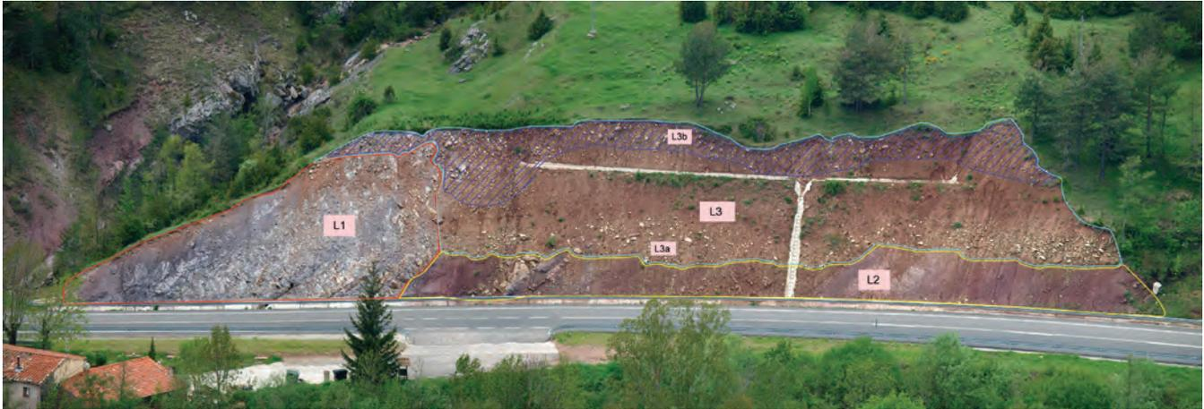
Figura 7. Esquema de las diferentes litologías que caracterizan el talud
