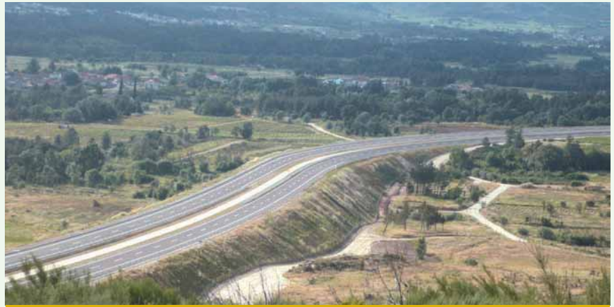
Terraplén, p.k. 5+400 al p.k. 6+600.
