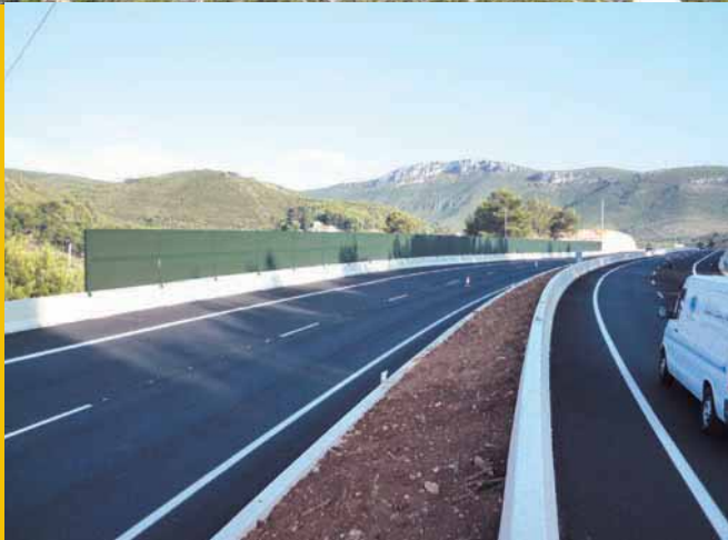
En las fotos superiores aparecen sendas vistas de los viaductos 2 (arriba) y 1 (centro) construidos para salvar el dominio hídrico del río Naixement. En la imagen inferior se aprecian las pantallas acústicas instaladas en la zona más cercana al núcleo urbano de Albaida.
