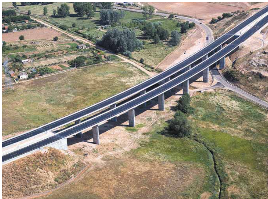
Viaducto (estructura E-7).
