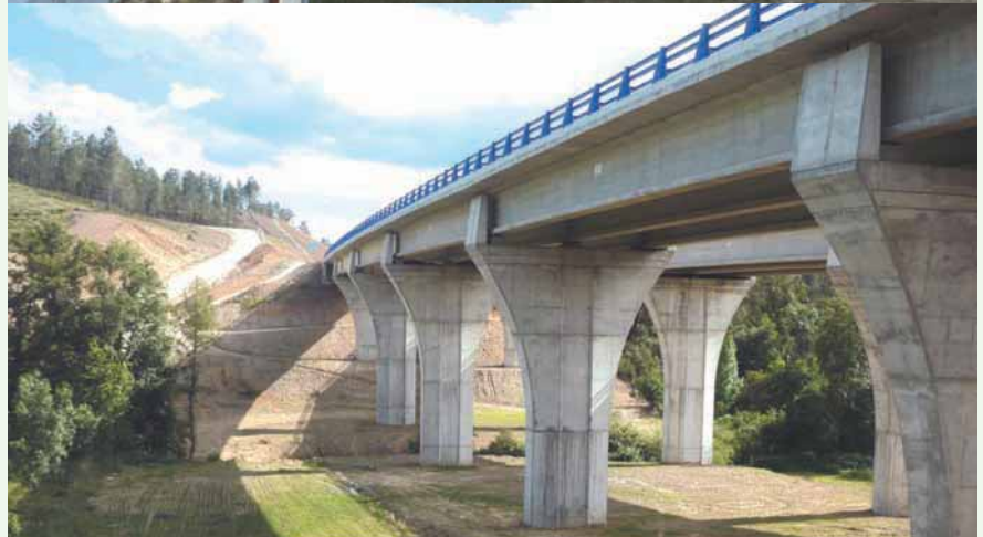
En la foto superior: Estructura mixta, paso superior A-52. Foto inferior: Vista desde la margen izquierda del viaducto de Arroyo Seco.
