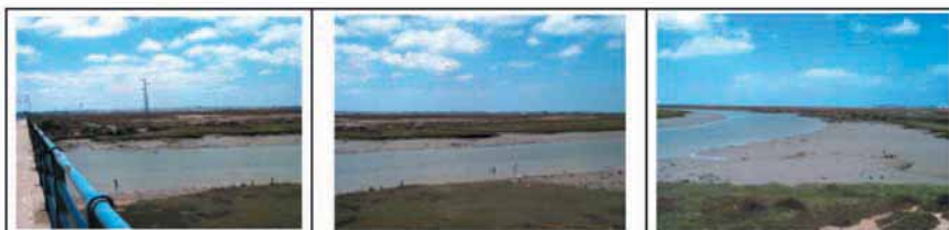
Inspección Principal de Cauce, en obra de paso pilotada. Datos fotográficos.
