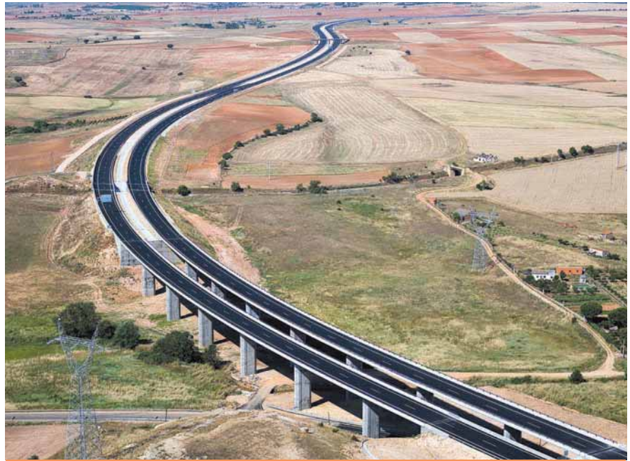
Vista panorámica del viaducto (estructura E-7) y del trazado desde el p.k. 3 hacia el final del tramo.
