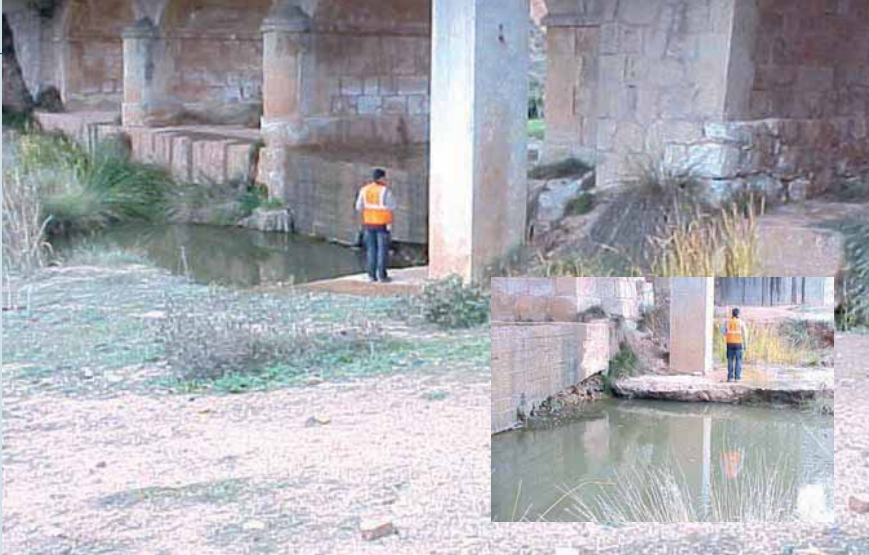
Inspección de la cimentación de un ensanche.
