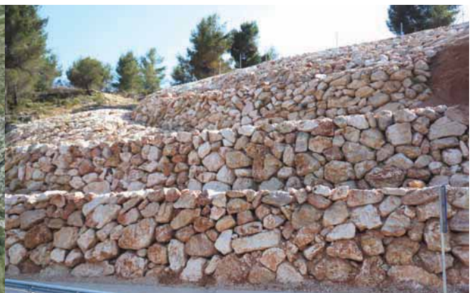
Vista aérea y detalle de los muros de escollera dispuestos en los pies de los taludes de desmontes para garantizar su estabilidad.
