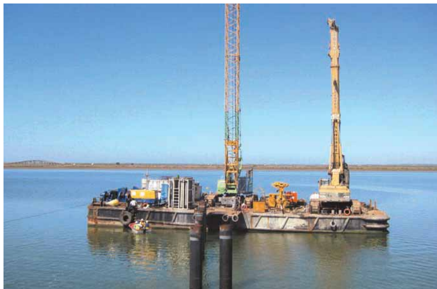
Figura 15. Equipos de pilotes sobre pontona para ampliación de pantalanes.
