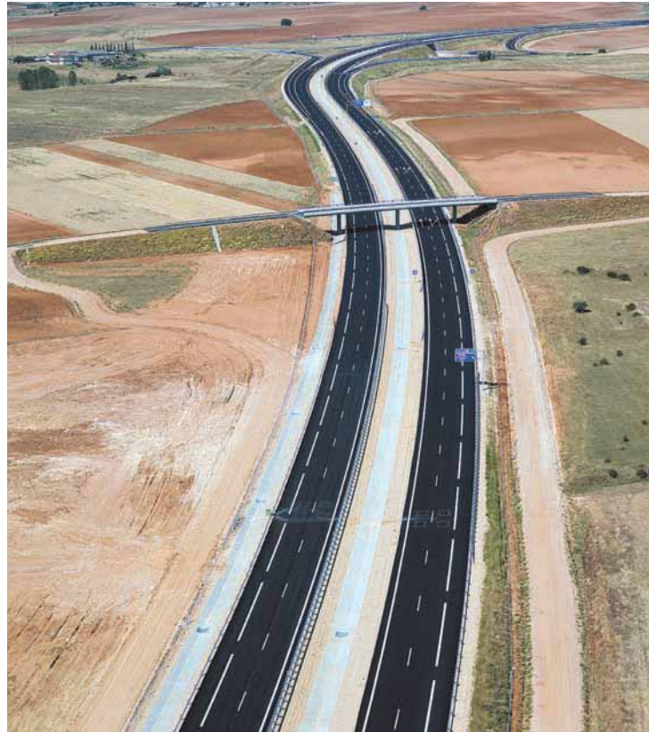
Vista panorámica del tramo en la que se observa la Estructura E-9, un paso de camino sobre la Ronda.
