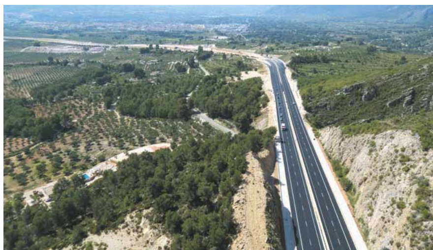
Vista panorámica de la autovía en su conexión con el futuro tramo Cocentaina-Muro de Alcoy.
