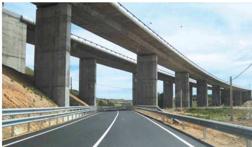
Detalle de los viaductos (estructura E-7).
