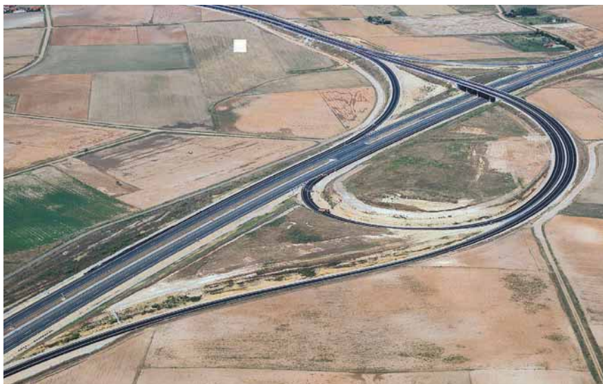
Enlace con la A-66 (estructura E-1).
