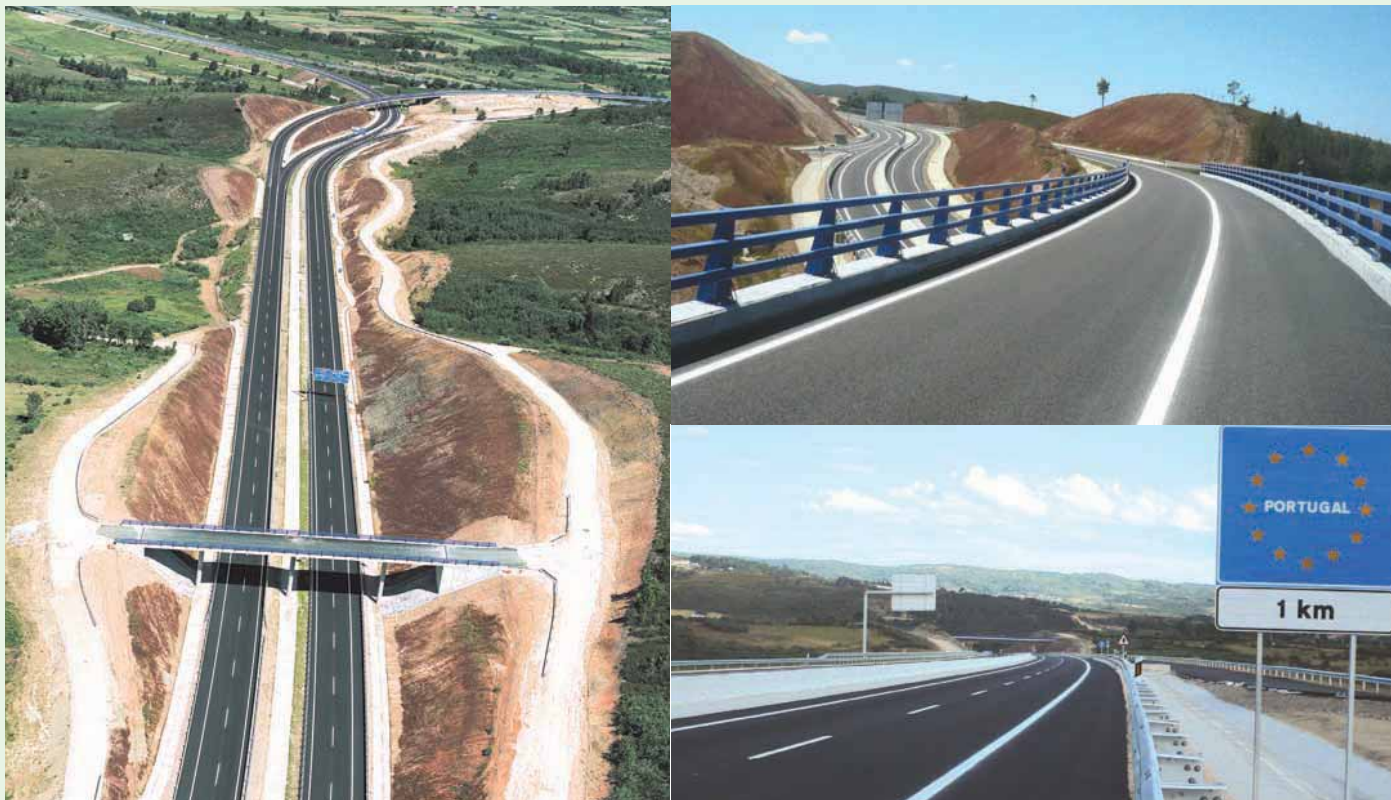
Vistas panorámicas de la autovía, de 12,7 km de longitud troncal y en la que se han dispuesto 2 enlaces, 3 viaductos, 5 pasos superiores, 8 pasos inferiores y 1 pasarela.
