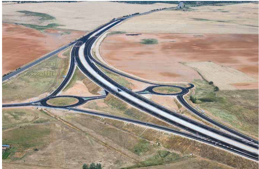
Vista aérea del enlace con la N-122 (estructura E-10).
