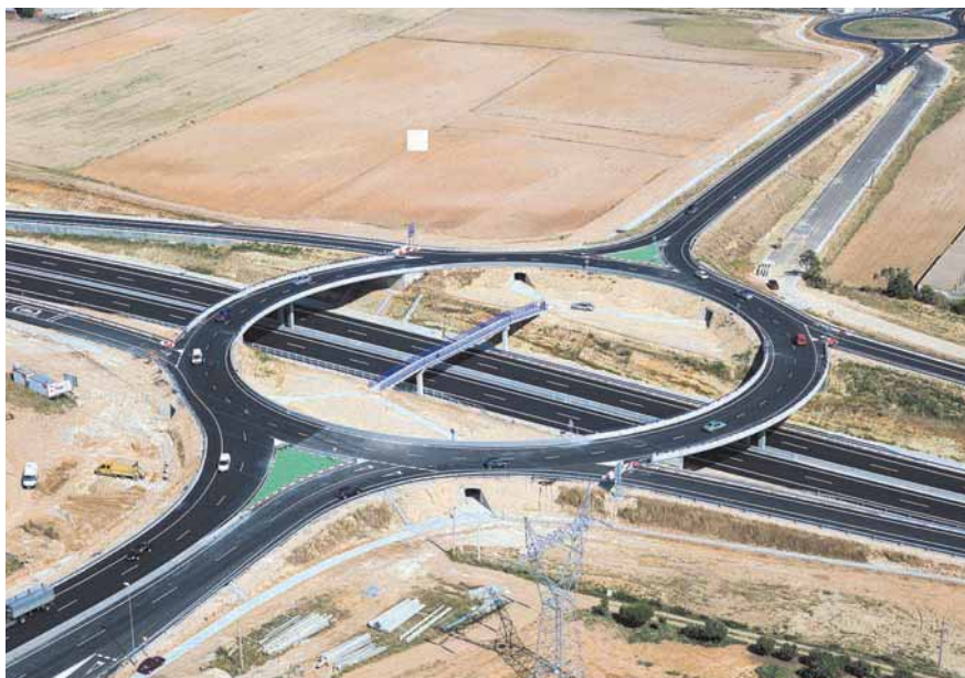
Reposición N-630 (estructuras E-4 y E-5).
