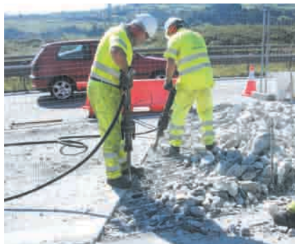
Foto 9. Demolición a mano de la banda de 70 cm para dejar la armadura vista.
