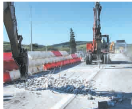
Foto 10. Demolición del resto de losa con martillo hidráulico.
