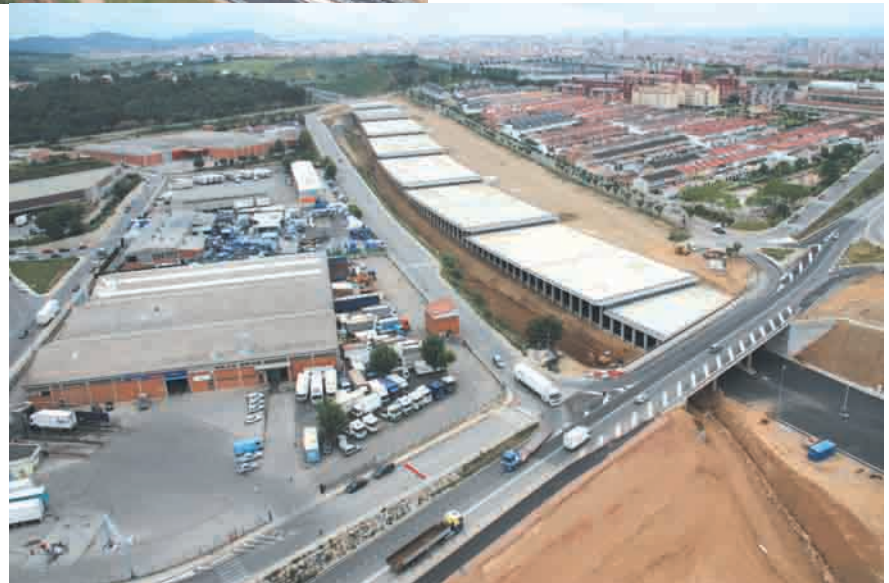
Vista de la cobertura de Can Trías y cajón hincado bajo Renfe.
