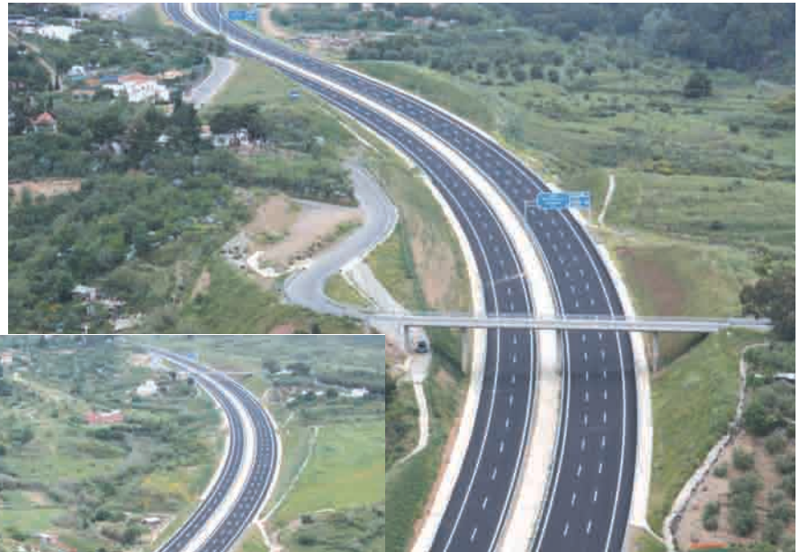
Vistas parciales del tramo que ha sido diseñado con un radio mínimo de 800 m y máximo de 2200 m.
