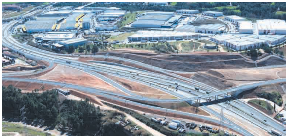
Conexión de la Autovía B-40 con la A-2, donde se observa el polígono de Sant Ermengol de fondo.
