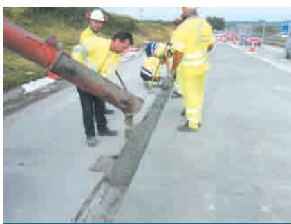
Foto 17. Hormigonado del hueco dejado por el encofrado longitudinal del arcén.
