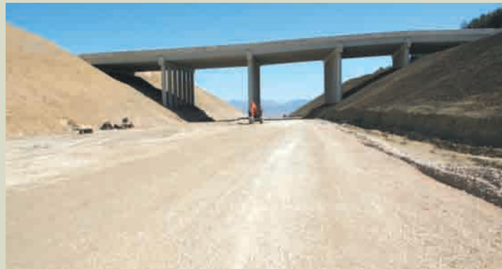
Las imágenes corresponden a la Autovía del Pirineo, actualmente en fase de construcción.
