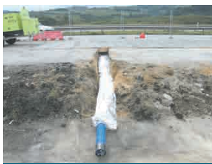
Foto 18. Salida del dren y reposición del arcén.
