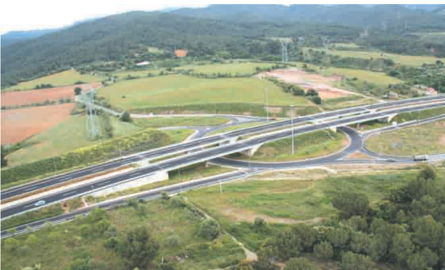
Vista del enlace de Terrassa Oeste desde otra perspectiva.
