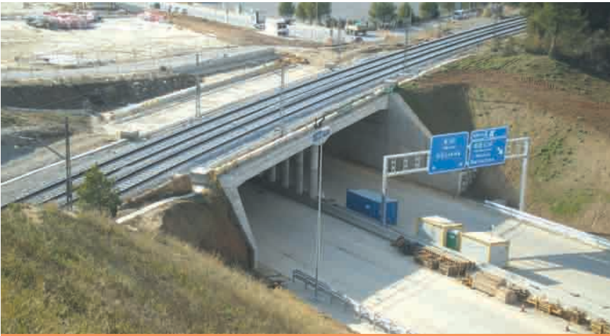
Cajón hincado finalizado.
