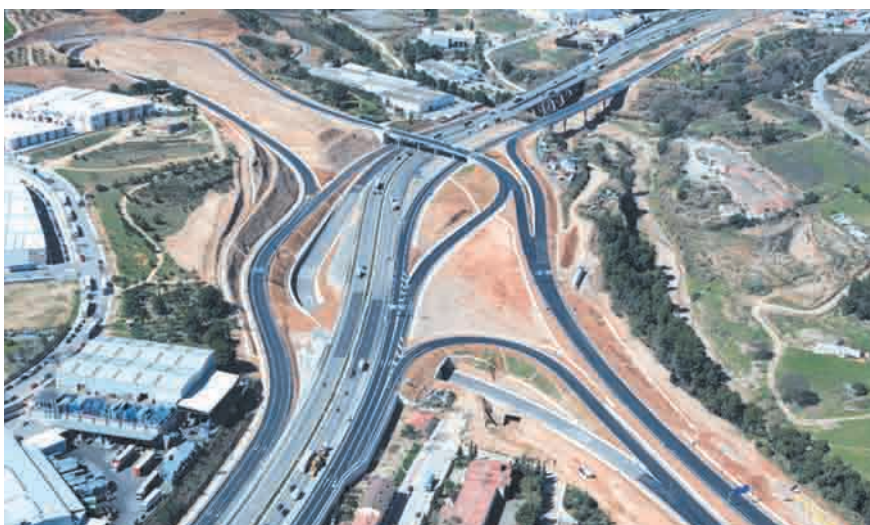
Vista aérea del enlace de Abrera Oeste.
