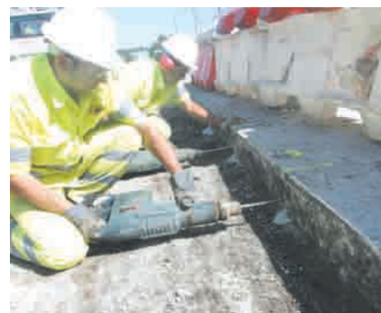
Foto 13. Perforación para las barras de atado.
