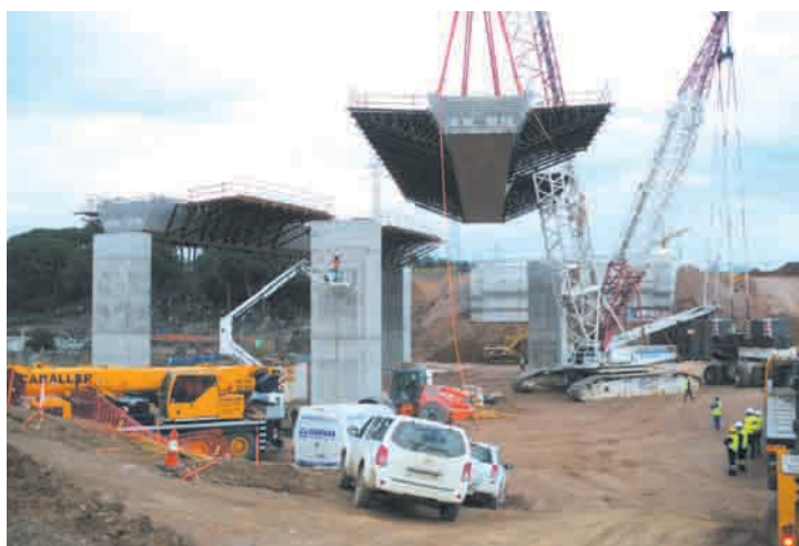
Montaje de las vigas del viaducto de Can Bogunyà.
