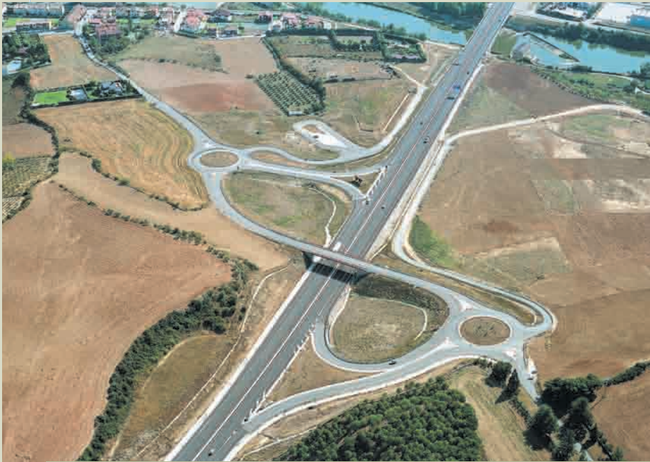
Vista aérea de la Autovía del Camino cuya construcción ha hecho posible una reducción importante en la siniestralidad y en el número de víctimas mortales en el itinerario.
