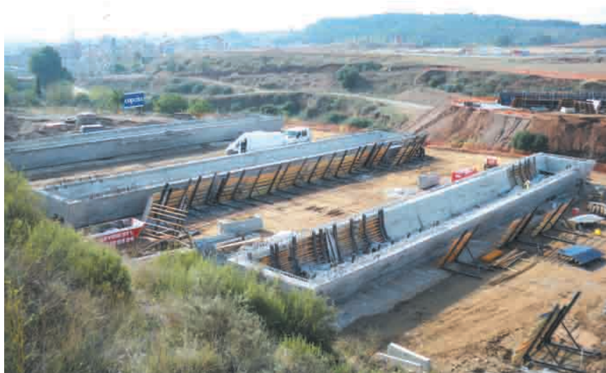
Construcción de las vigas del viaducto de Can Bogunyà.
