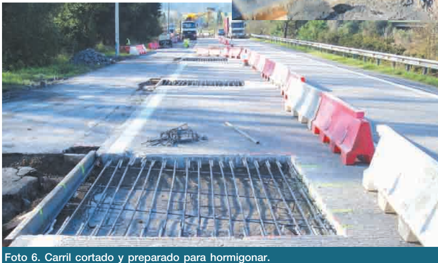
Foto 6. Carril cortado y preparado para hormigonar.
