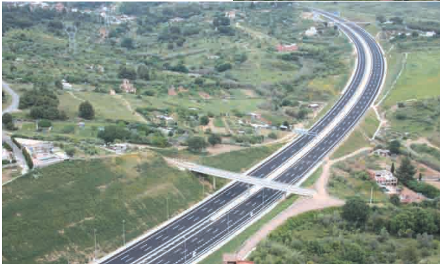
Vistas parciales del tramo que ha sido diseñado con un radio mínimo de 800 m y máximo de 2200 m.
