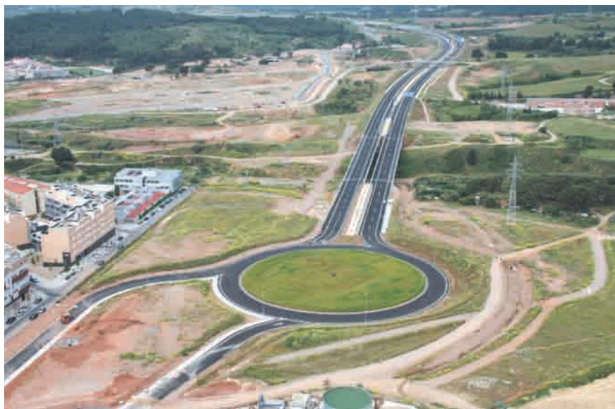
Finalización del tramo. Conexión Terrassa Norte.
