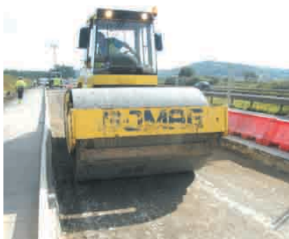
Foto 11. Saneo y reparación de la base con HM-15.
