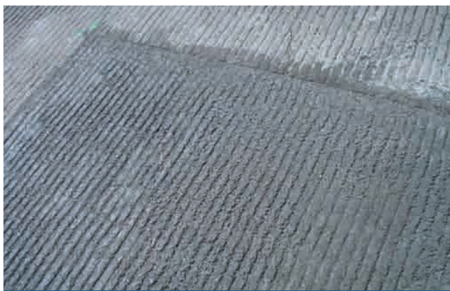
Foto 20. Reparación después de dos días de tráfico.
