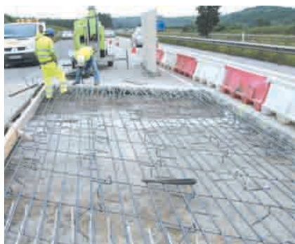
Foto 12. Colocación de la armadura.
