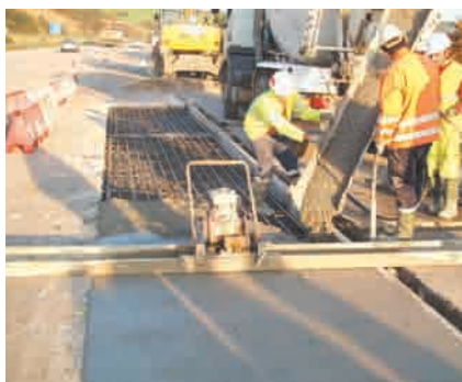
Foto 14. Hormigonado y terminación con regla vibrante.
