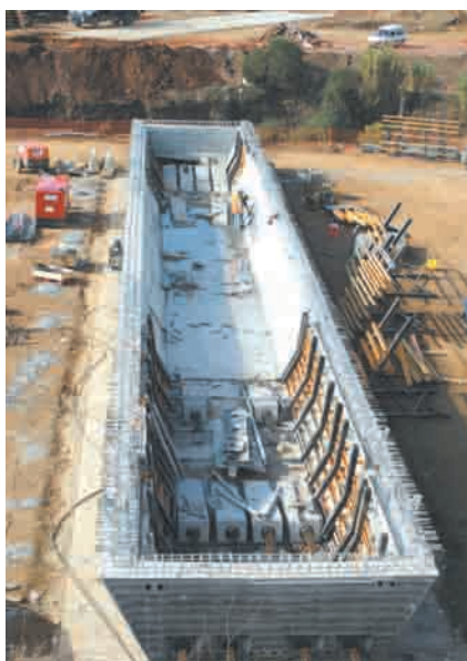
Viga prefabricada en obra.
