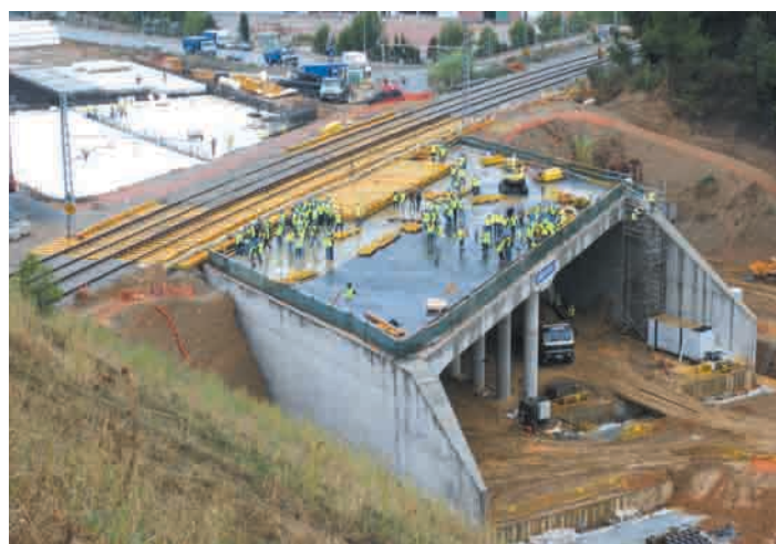
Empuje del cajón hincado.
