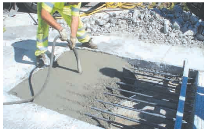
Foto 21. Colocación y vibrado del hormigón.
