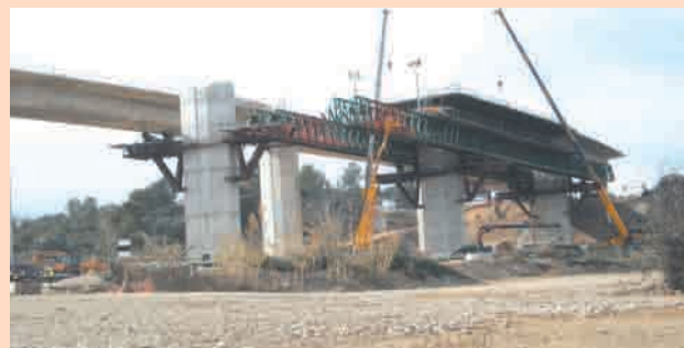
Colección de imágenes donde se aprecia la ejecución del Viaducto del Llobregat mediante cimbra autoportante.
