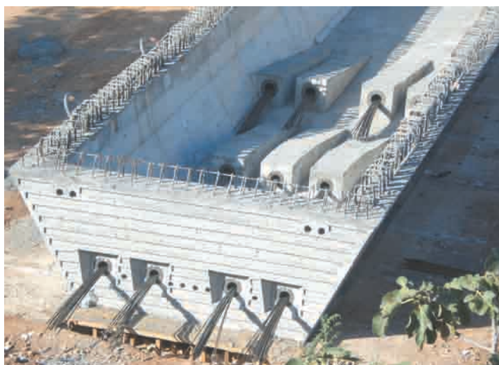
Detalle de los anclajes de las vigas.
