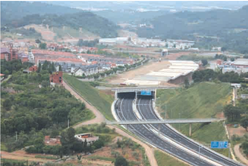
Vista de la cobertura de Can Trías y paso superior de la carretera C-58.
