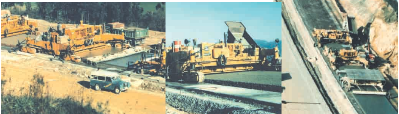
Fotos 1 a 3. Imágenes de construcción del pavimento de hormigón armado durante 1974-75.
