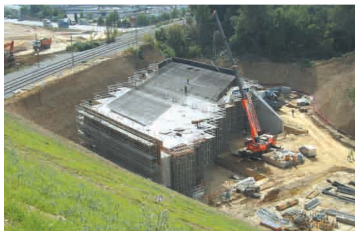
Construcción del cajón hincado.
